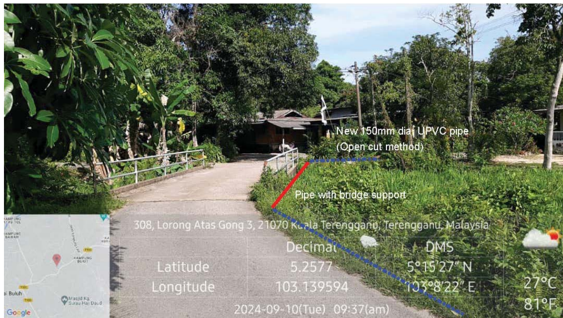
GAMBAR 2 : Kawasan cadangan laluan paip baru dan lintasan parit (jambatan laluan paip dibina).
