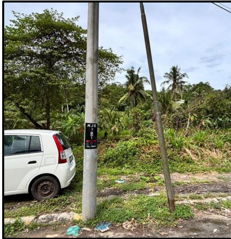
GAMBAR 5: TIANG TNB DI CH5130 (5.42574°N, 101.12437°E)
