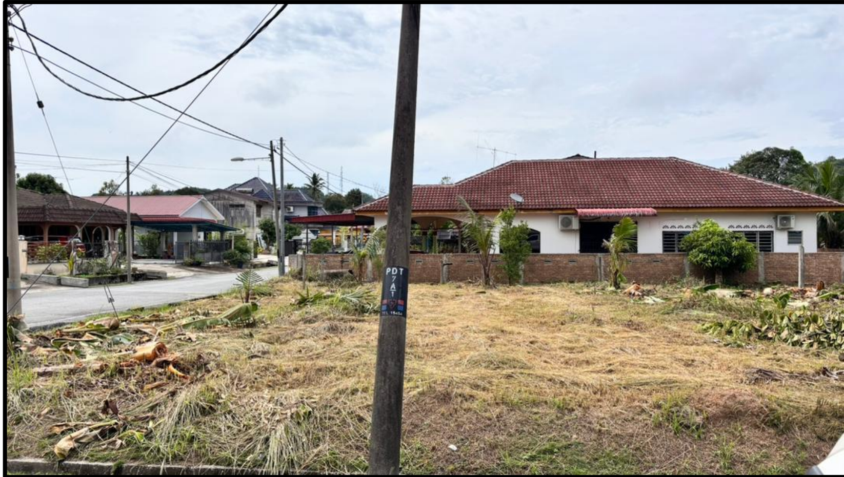
GAMBAR 17: TIANG TNB DI CH5350 (5.42682°N, 101.12255°E)
