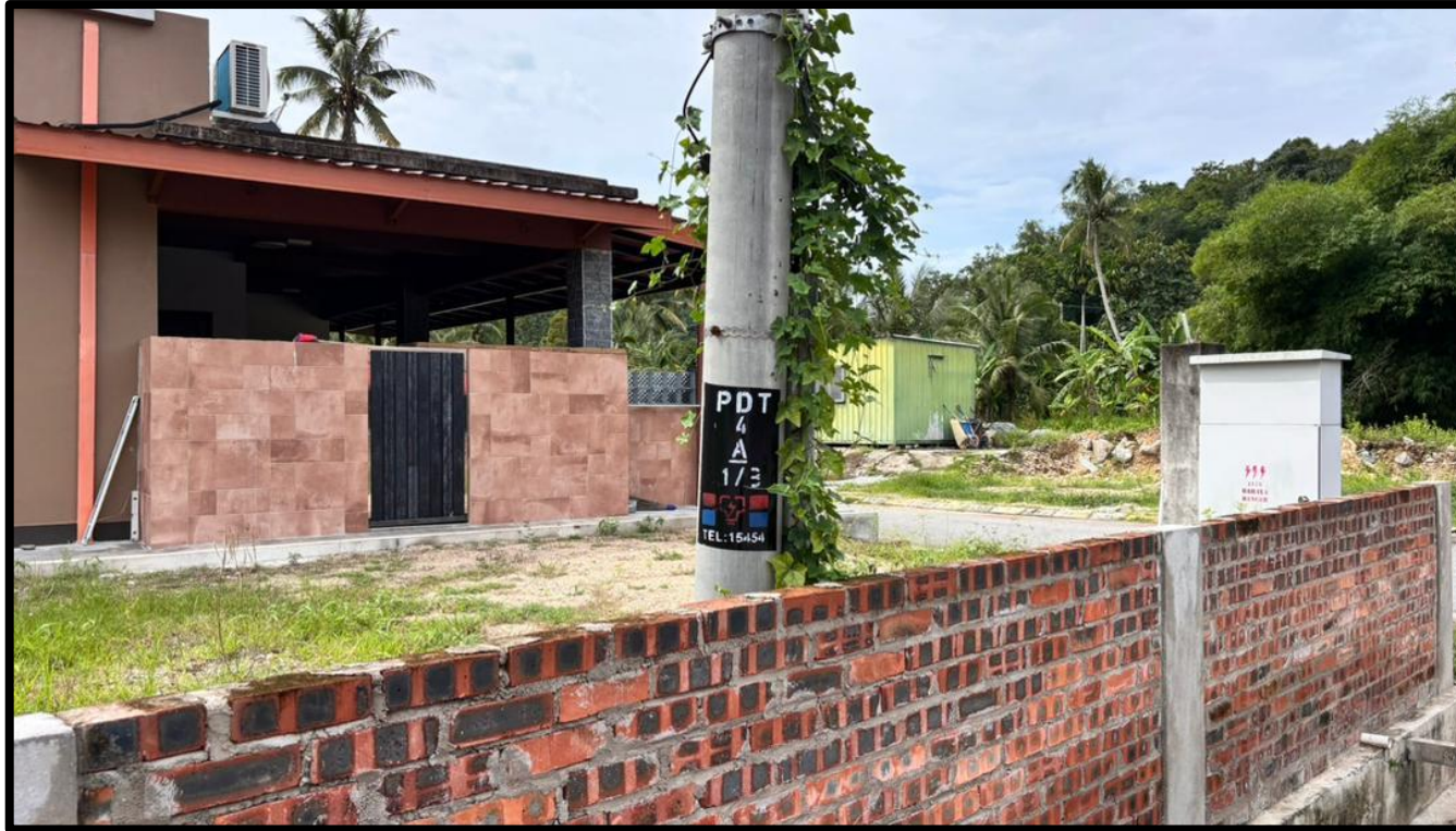
GAMBAR 4: TIANG TNB DI CH5160 (5.42609°N, 101.12358°E)
