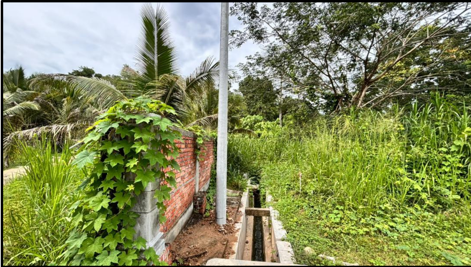
GAMBAR 14: TIANG TNB DI CH5350 (5.42610°N, 101.12240°E)
