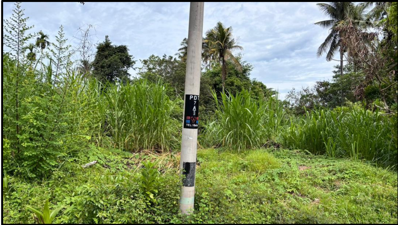
GAMBAR 15: TIANG TNB DI CH5350 (5.42630°N, 101.12246°E)
