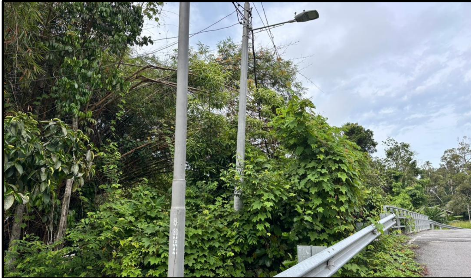
GAMBAR 19: TIANG TNB DI CH5500 (5.42715°N, 101.12159°E)
