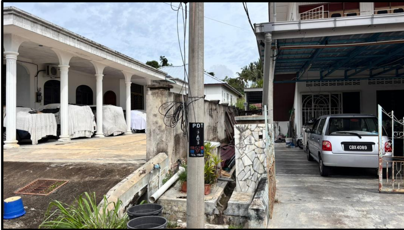
GAMBAR 9: TIANG TNB DI CH5250 (5.42614°N, 101.12299°E)
