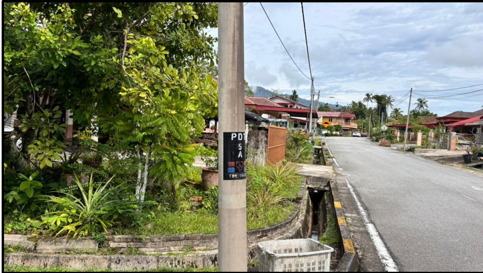
GAMBAR 12: TIANG TNB DI CH5250 (5.42674°N, 101.12317°E)
