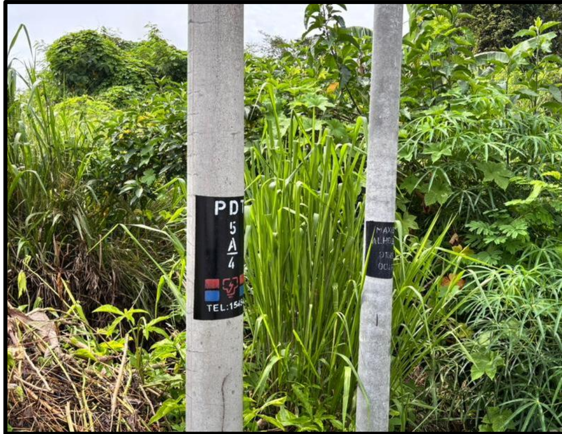
GAMBAR 8: TIANG TNB DI CH5240 (5.42595°N, 101.12292°E)
