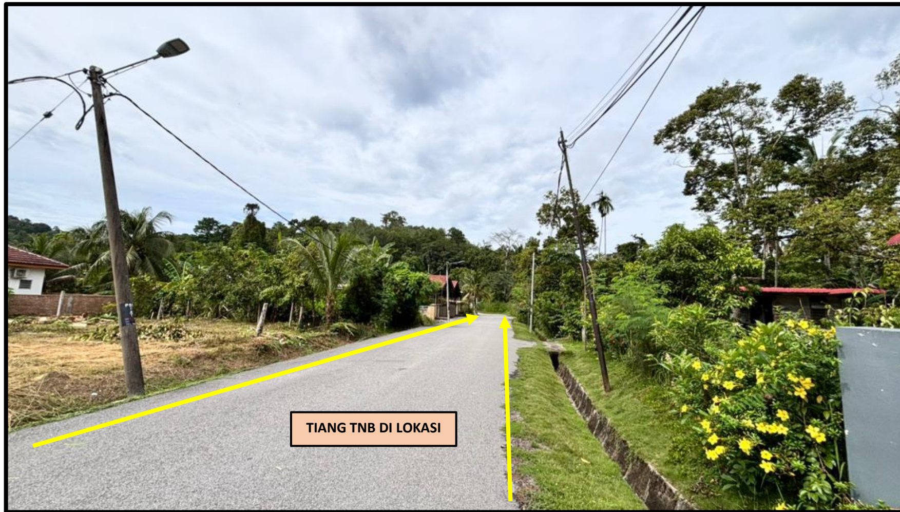
GAMBAR 18: LOKASI TIANG TNB DI CH5350 (5.42687°N, 101.12257°E)
