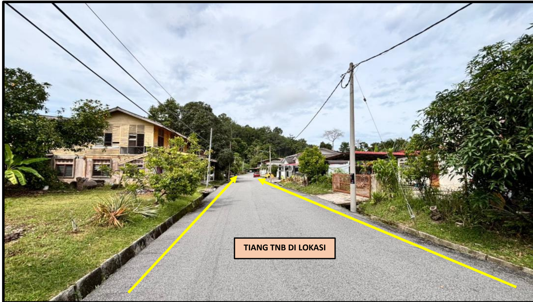
GAMBAR 13: LOKASI TIANG TNB DI CH5250 (5.42668°N, 101.12318°E)
