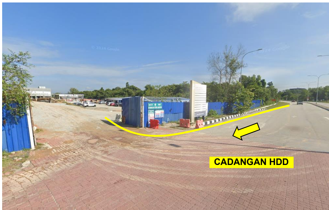
GAMBAR 4: KAWASAN KERJA MELIBATKAN 'HORIZONTAL DIRECTIONAL DRILLING'
