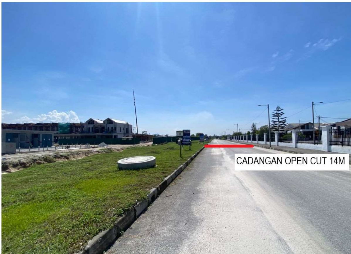
GAMBAR 1 : KAWASAN KERJA MELIBATKAN PEMOTONGAN JALAN (OPEN CUT)
