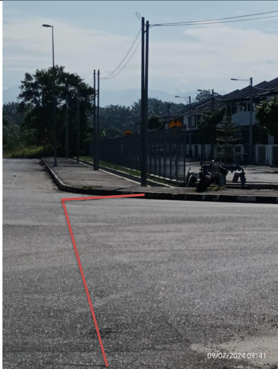
KAWASAN KERJA MELIBATKAN PEMOTONGAN JALAN (OPEN CUT)
