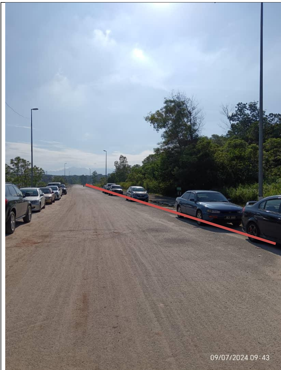
KAWASAN KERJA MELIBATKAN PEMOTONGAN JALAN (OPEN CUT)
