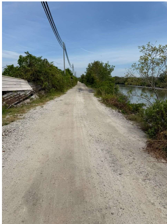
Gambar 2: Kawasan kerja melibatkan korekan jalan tidak berturap
