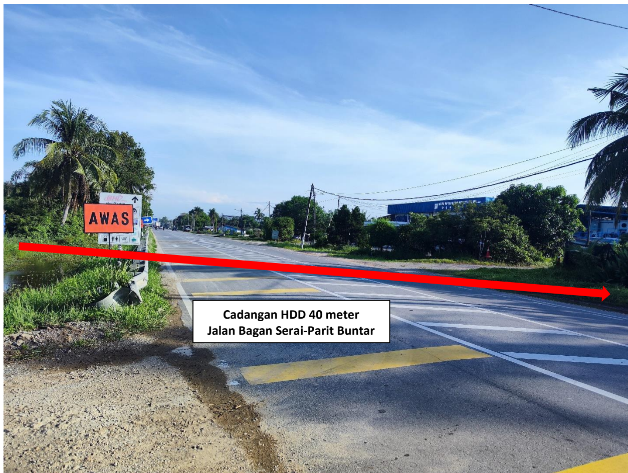
Gambar 1 : Kawasan Kerja melibatkan Horizontal Directional Drilling
