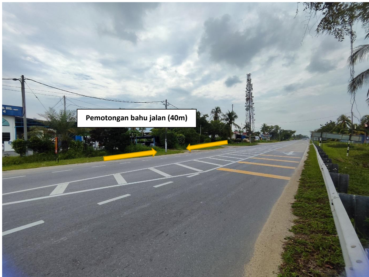
Gambar 2 : Kawasan Kerja melibatkan pemotongan bahu jalan
