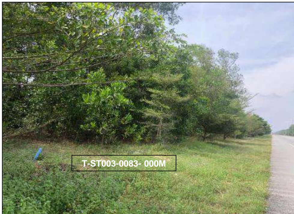
LOCATION AT JALAN KAMPUNG PENARIK-KAMPUNG KUALA ABANG
