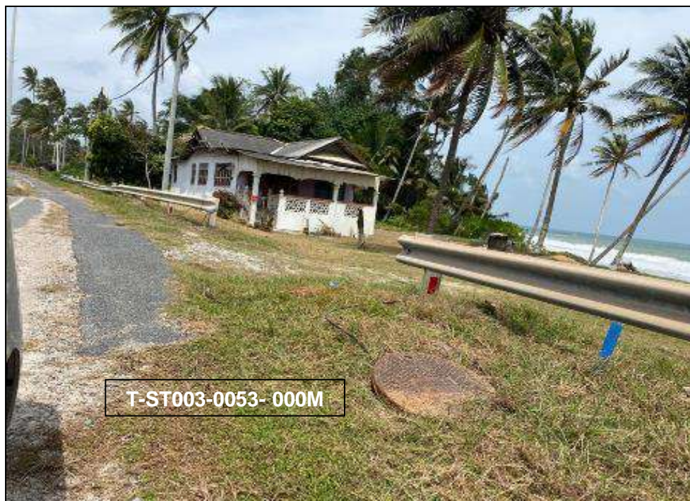
LOCATION AT JALAN KAMPUNG PENARIK-KAMPUNG KUALA ABANG
