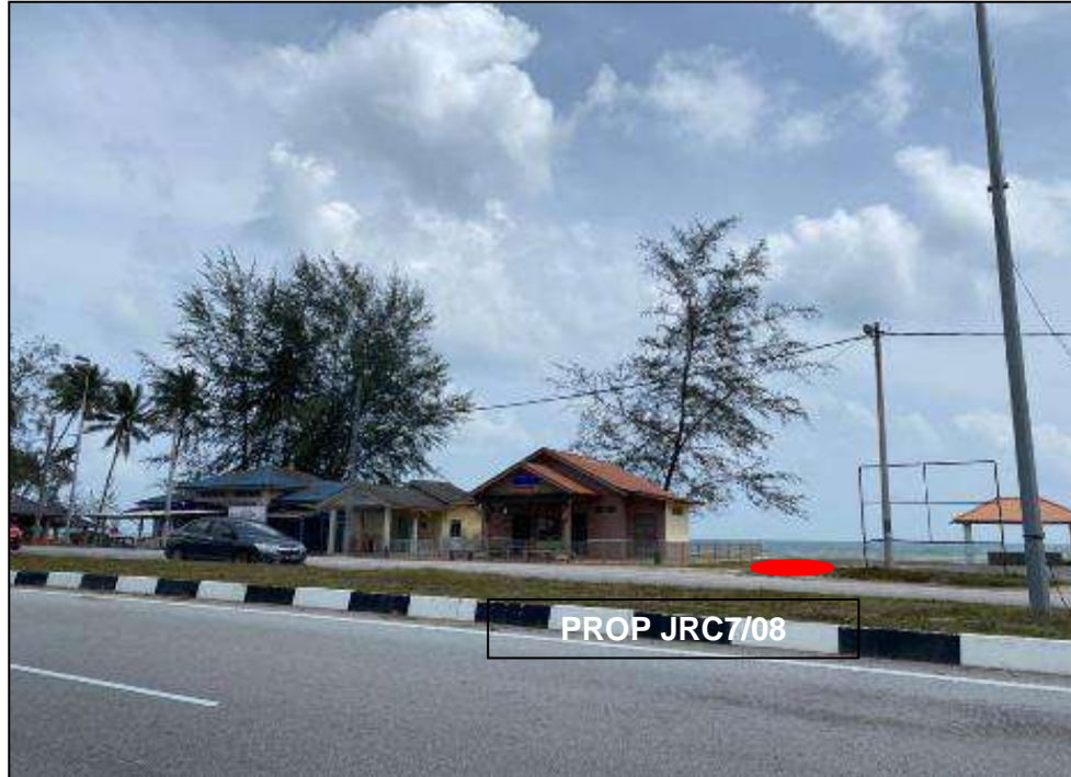
LOCATION AT JALAN KAMPUNG PENARIK-KAMPUNG KUALA ABANG
