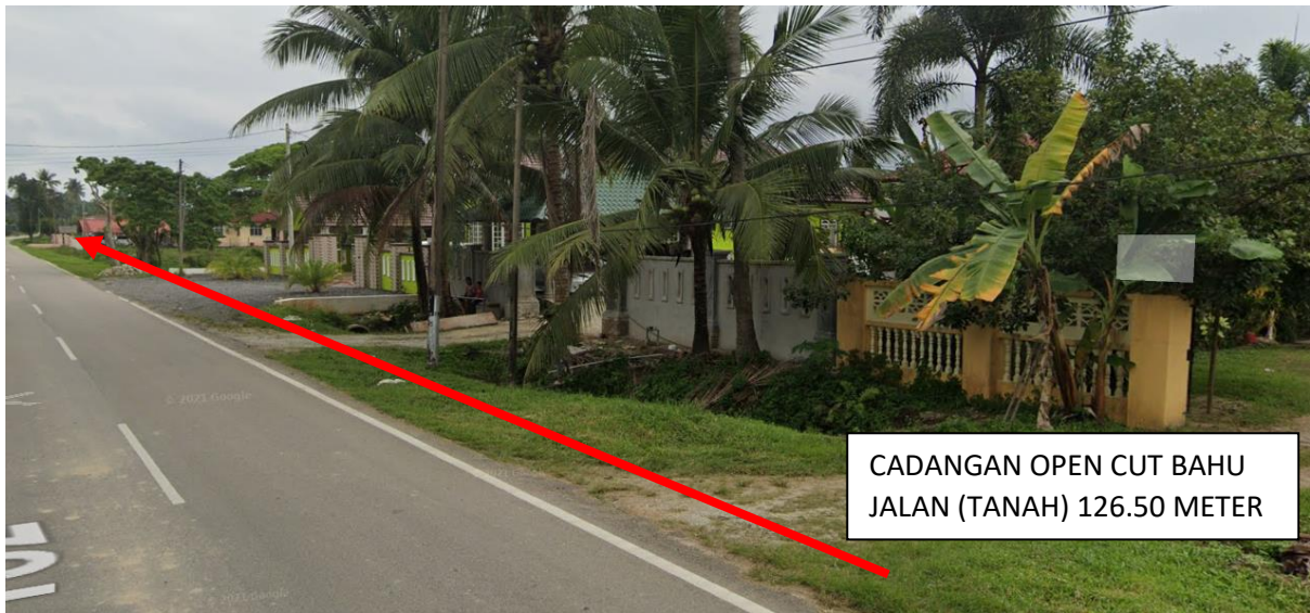
GAMBAR 1 : KAWASAN KERJA MELIBATKAN PEMOTONGAN BAHU JALAN (TIDAK BERTAR)
