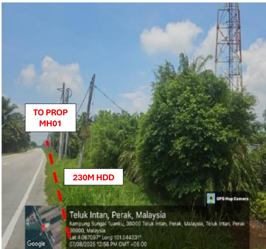
PICTURE 2 : HDD 230METER TO PROPOSE MH01
