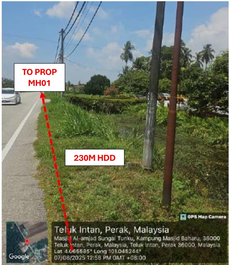
PICTURE 4 : HDD 230METER TO PROPOSE MH01
