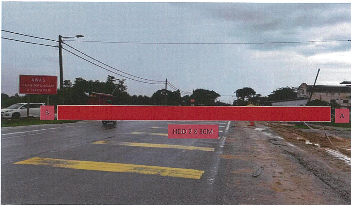
KAWASAN KERJA MELIBATKAN OPEN CUT DI ATAS JALAN BERTAR
