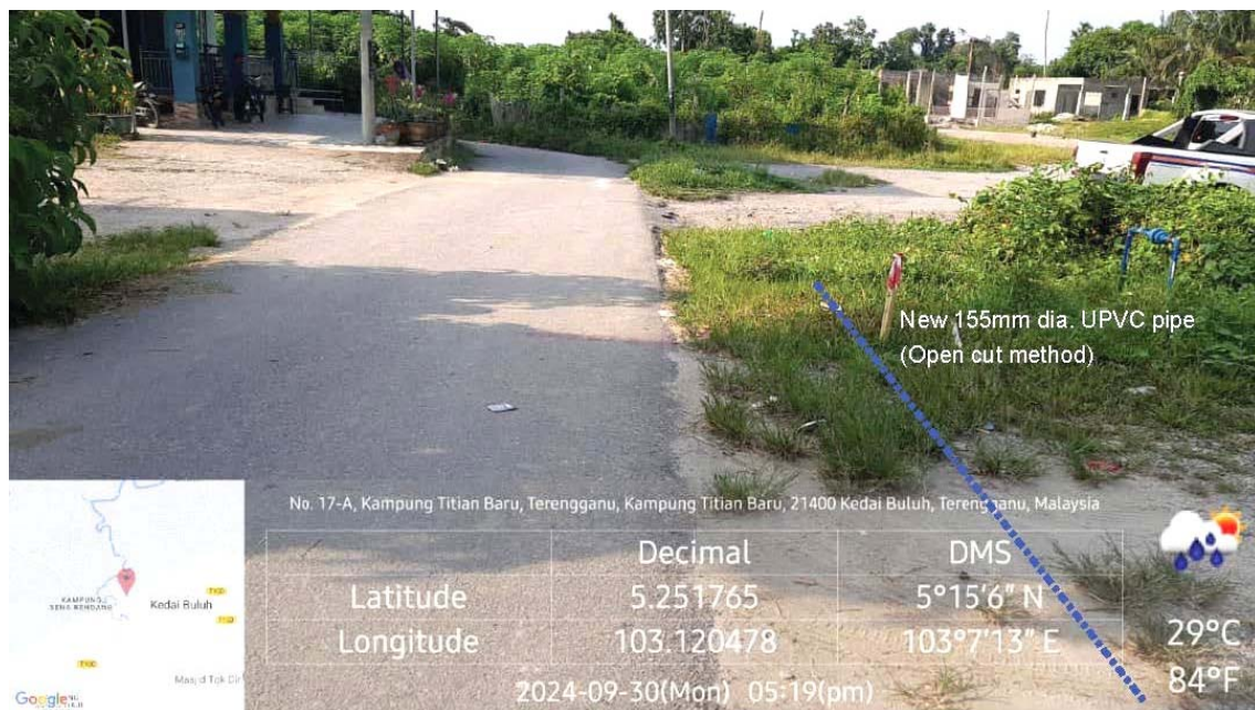
GAMBAR 6 : Kawasan cadangan laluan paip baru pada laluan jalan.
