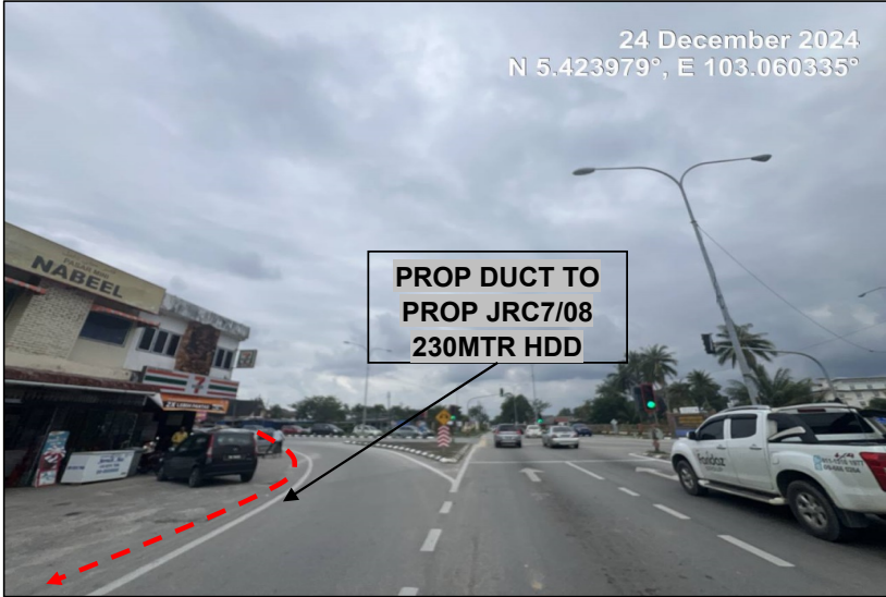
LOCATION AT JALAN TENGGU AMPUAN INTAN ZAHARAH (3685)
