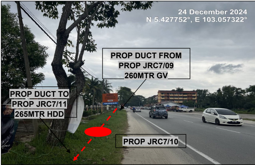
LOCATION AT JALAN TENGGU AMPUAN INTAN ZAHARAH (3685)
