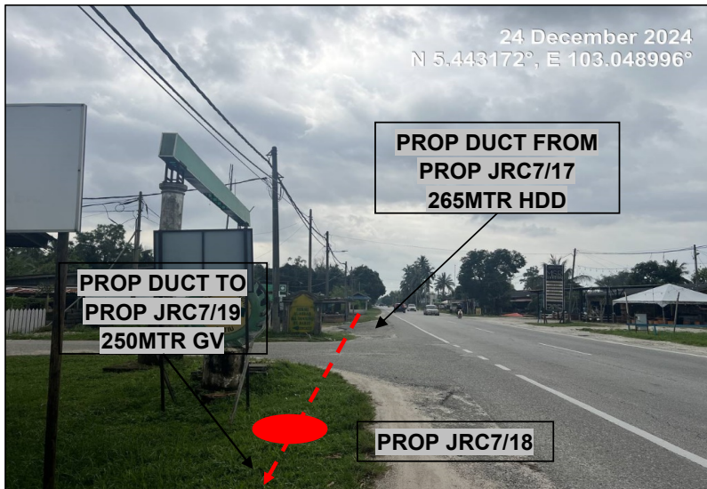
LOCATION AT JALAN TENGGU AMPUAN INTAN ZAHARAH (3685)
