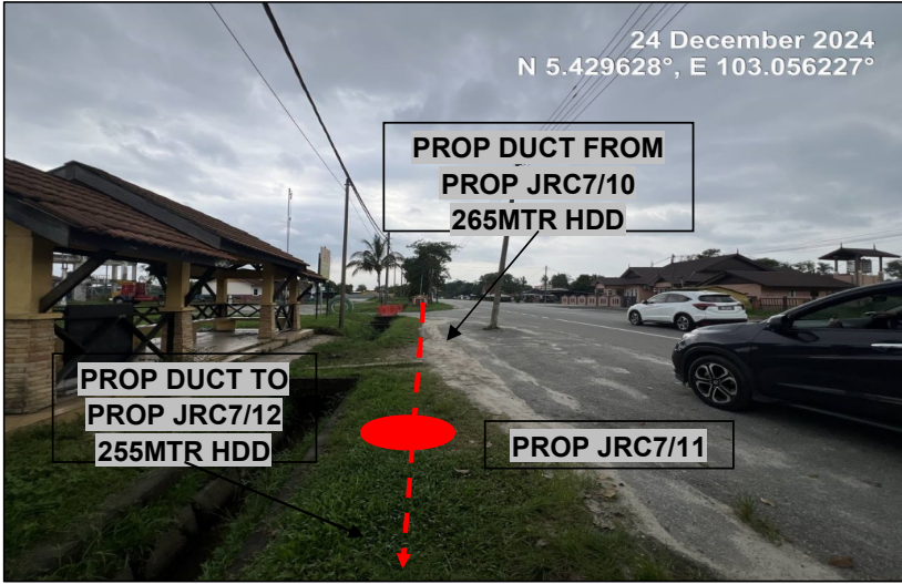
LOCATION AT JALAN TENGGU AMPUAN INTAN ZAHARAH (3685)
