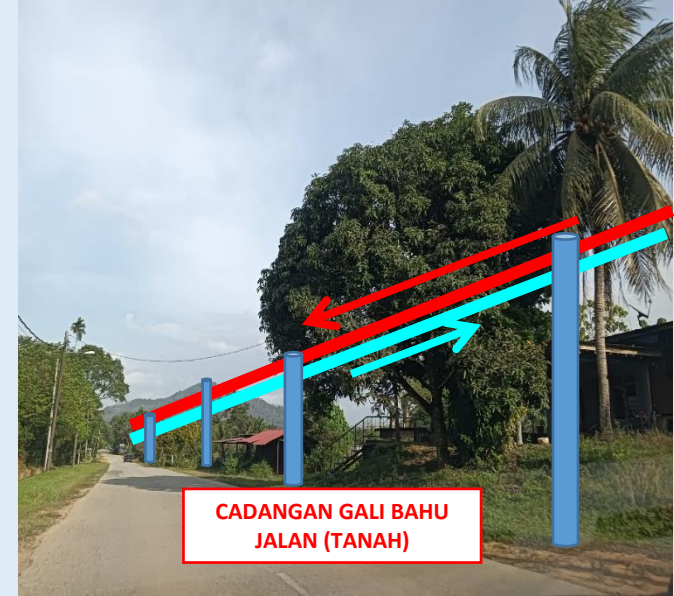
GAMBAR 6 : KAWASAN KERJA MELIBATKAN TANAM TIANG 7.5M (BERTANAH)
