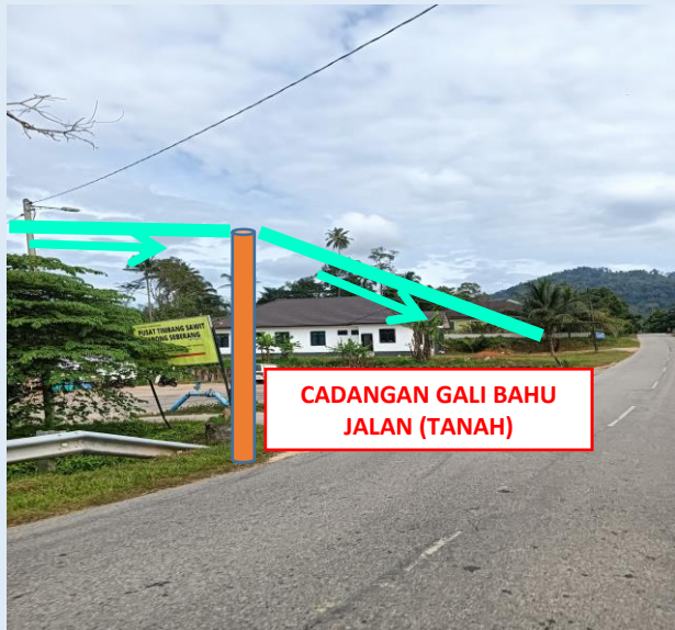
GAMBAR 15 : KAWASAN KERJA MELIBATKAN TANAM TIANG 9M (BERTANAH)
