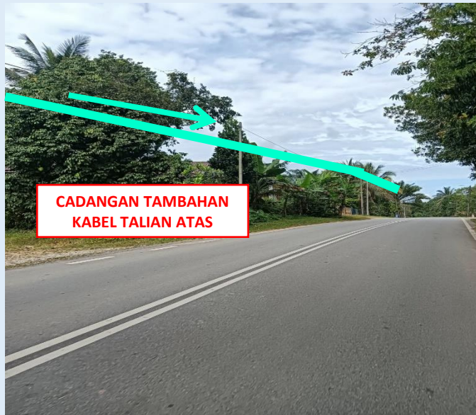
GAMBAR 19 : KAWASAN KERJA MELIBATKAN PENAMBAHAN KABEL TALIAN ATAS
