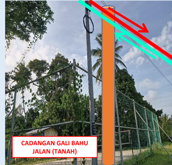
GAMBAR 14 : KAWASAN KERJA MELIBATKAN TANAM TIANG 9M (BERTANAH)
