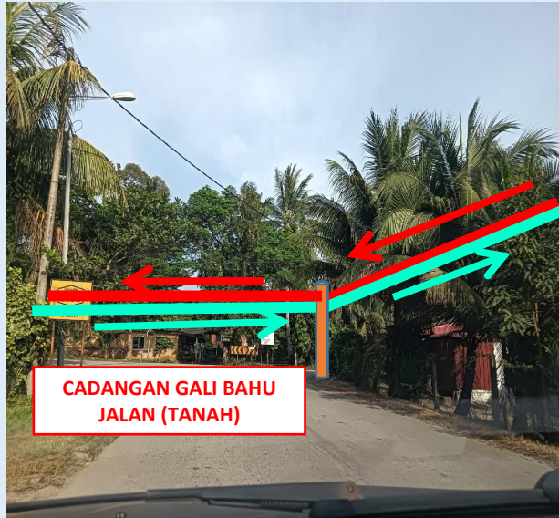
GAMBAR 13 : KAWASAN KERJA MELIBATKAN TANAM TIANG 9M (BERTANAH)
