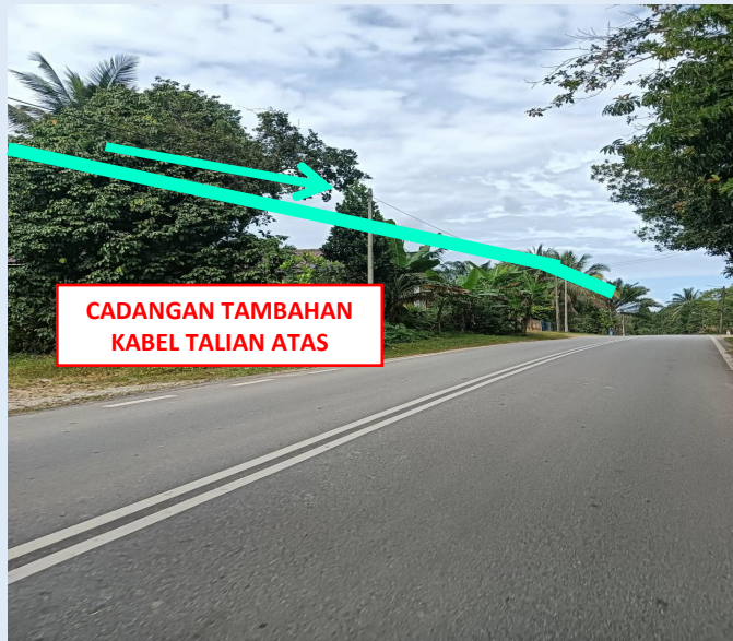
GAMBAR 19 : KAWASAN KERJA MELIBATKAN PENAMBAHAN KABEL TALIAN ATAS
