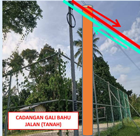
GAMBAR 14 : KAWASAN KERJA MELIBATKAN TANAM TIANG 9M (BERTANAH)
