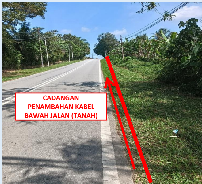
GAMBAR 3 : KAWASAN KERJA MELIBATKAN PENAMBAHAN KABEL (BERTANAH)
