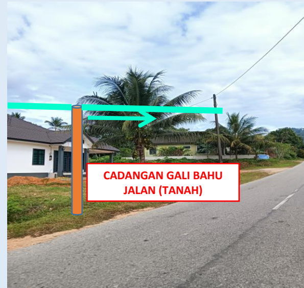
GAMBAR 16 : KAWASAN KERJA MELIBATKAN TANAM TIANG 9M (BERTANAH)
