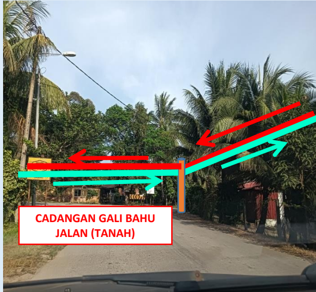
GAMBAR 13 : KAWASAN KERJA MELIBATKAN TANAM TIANG 9M (BERTANAH)
