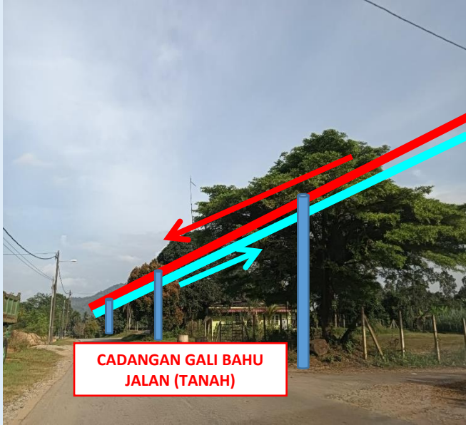
GAMBAR 5 : KAWASAN KERJA MELIBATKAN TANAM TIANG 7.5M (BERTANAH)
