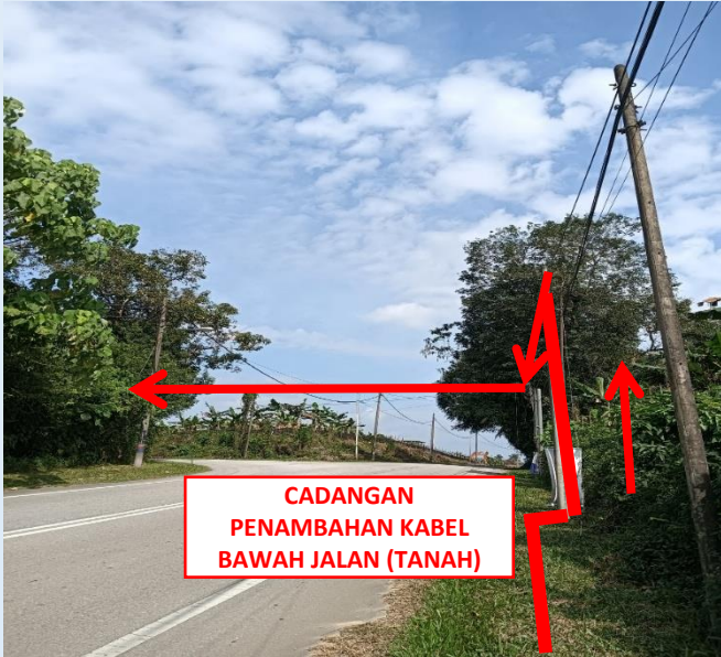
GAMBAR 4 : KAWASAN KERJA MELIBATKAN PENAMBAHAN KABEL (BERTANAH)
