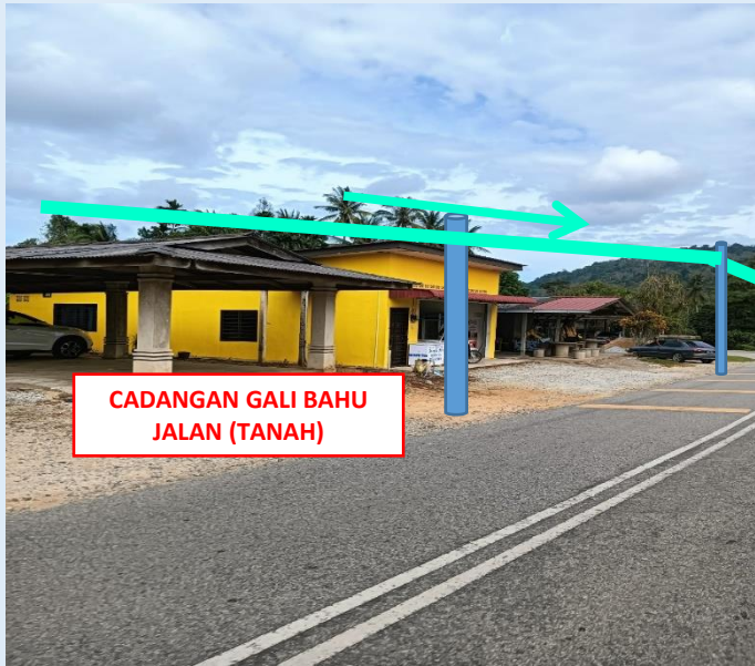
GAMBAR 9 : KAWASAN KERJA MELIBATKAN TANAM TIANG 7.5M (BERTANAH)
