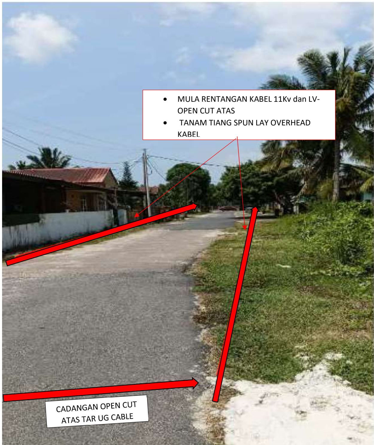
GAMBAR 2: RENTANGAN MELIBATKAN OPEN CUT TANAH & TAR
