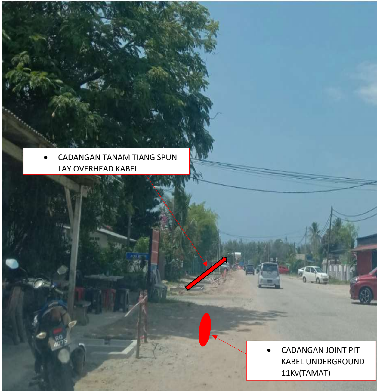
GAMBAR 3: CADANGAN JOINT PIT(EP) DAN LALUAN TANAM TIANG SPUN.
