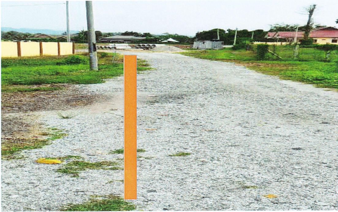
KAWASAN KERJA MELIBATAN OPEN CUT DI ATAS TANAH
