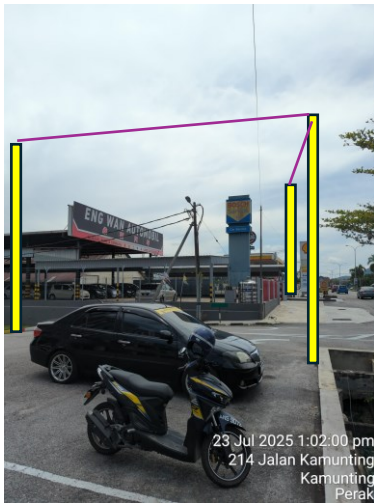
PROP POLE AT JALAN KAMUNTING
