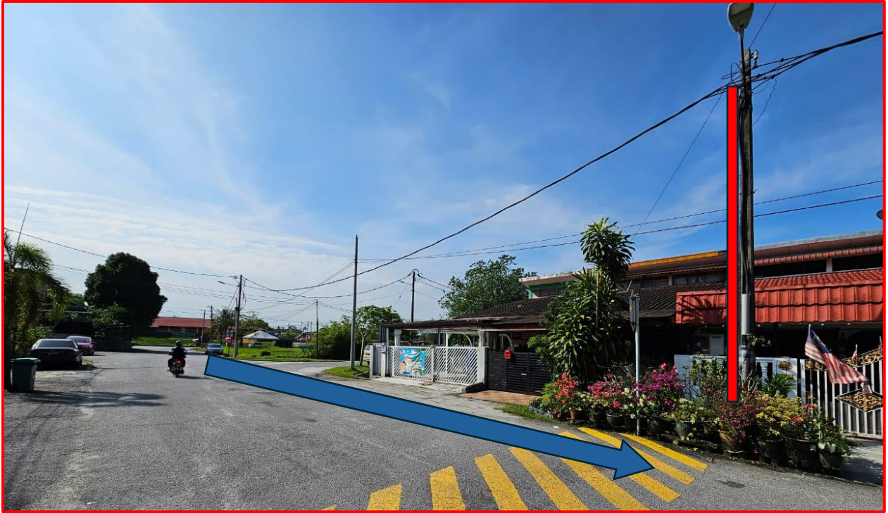
Gambar 5: Kawasan jalan melibatkan pemotongan ke tiang rumah pengguna
