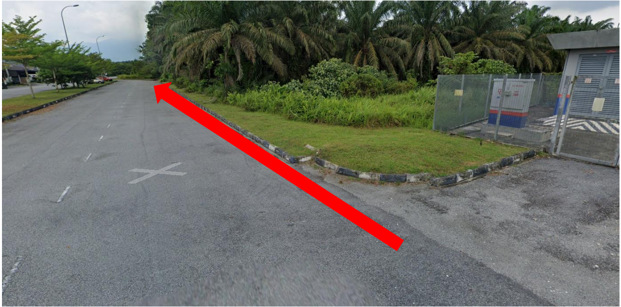
GAMBAR 2 (KAWASAN KERJA YANG MELIBATKAN OPEN CUT)
