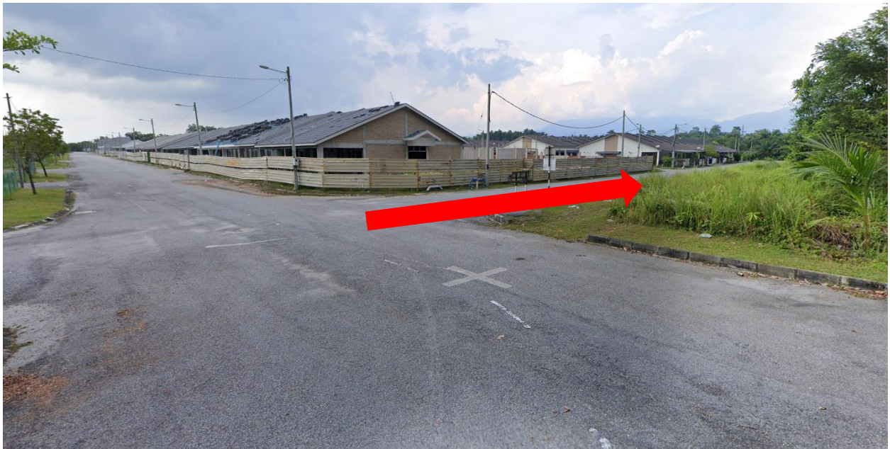
GAMBAR 3 (KAWASAN KERJA YANG MELIBATKAN OPEN CUT)
