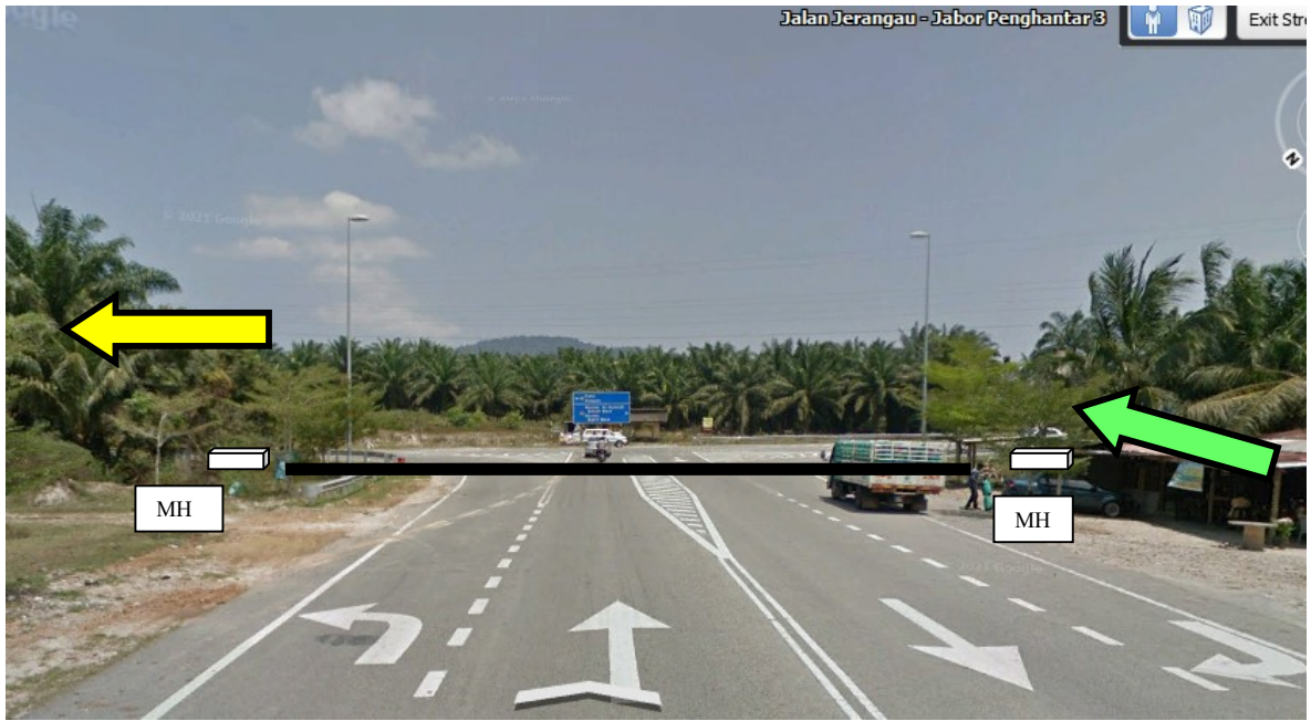
Laluan kanan jalan sehingga simpang jln 122. HDD menyeberang jalan.
