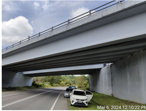
Menyeberangi Bawah Highway LPT2 – HDD ( 4.602039° 103.356439°)
