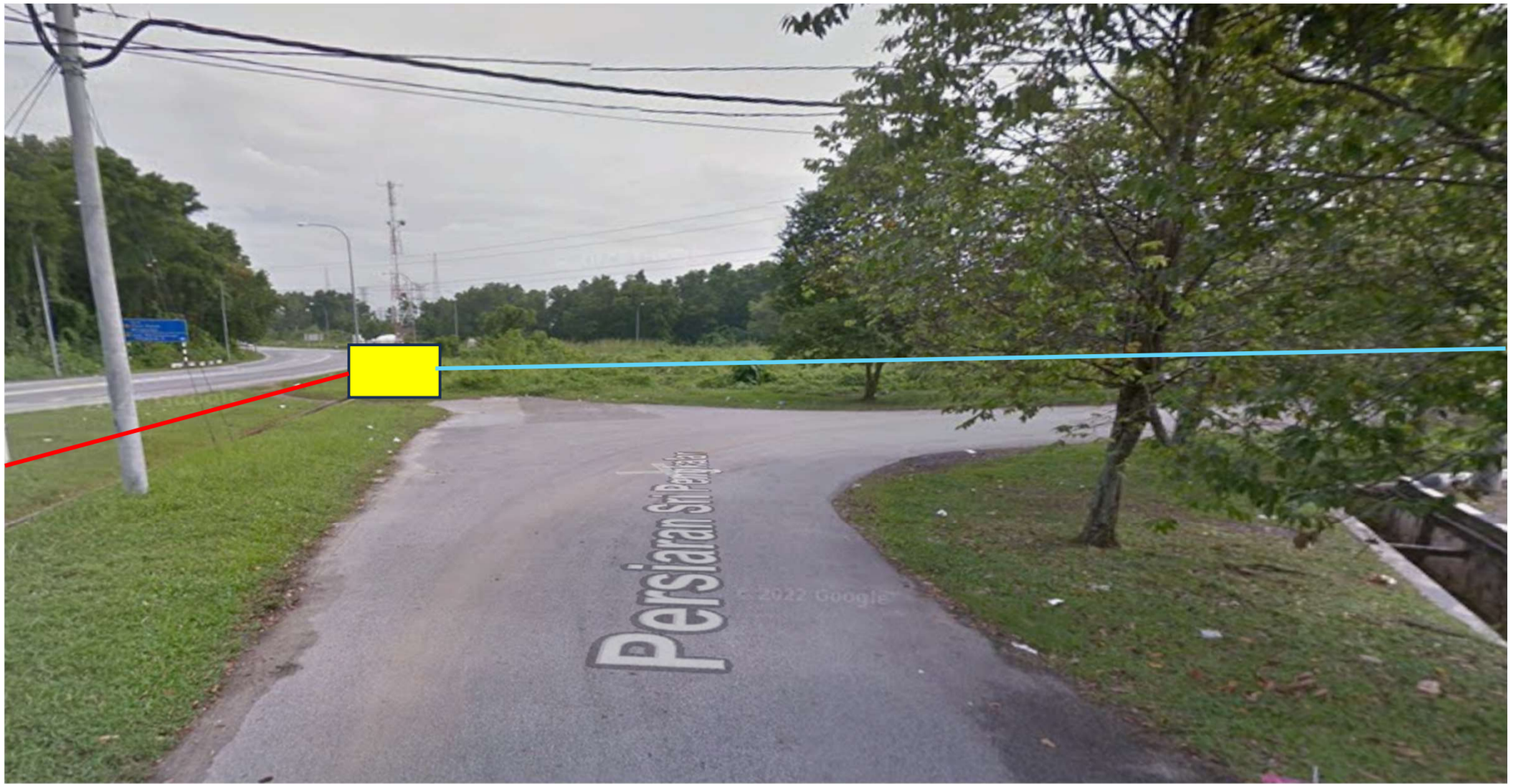
JALAN LAHAT – PRSN SRI PENGKALAN 4 HDD & OPEN CUT
