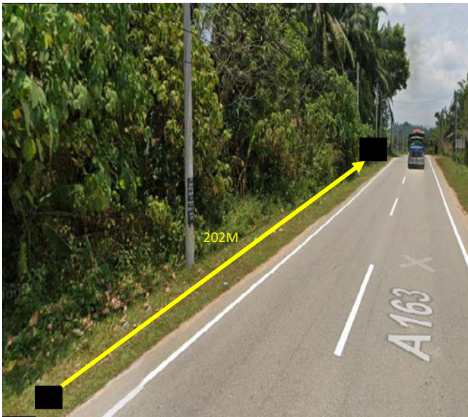
Gambar 2: Kerja kerja menarik kabel 96C UG MH to MH sedia ada (Tidak Berturap)
