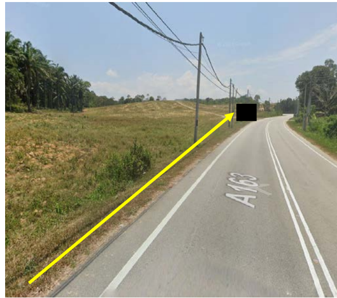
Gambar 8.1: Kerja kerja menarik kabel 96C UG MH to MH sedia ada (Tidak Berturap)
