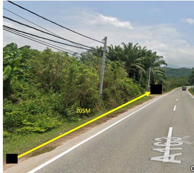
Gambar 3: Kerja kerja menarik kabel 96C UG MH to MH sedia ada (Tidak Berturap)
