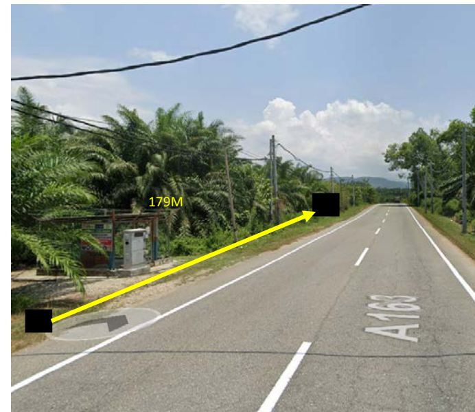
Gambar 5: Kerja kerja menarik kabel 96C UG MH to MH sedia ada (Tidak Berturap)
