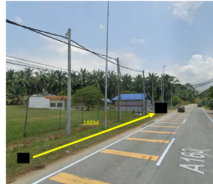
Gambar 6: Kerja kerja menarik kabel 96C UG MH to MH sedia ada (Tidak Berturap)
