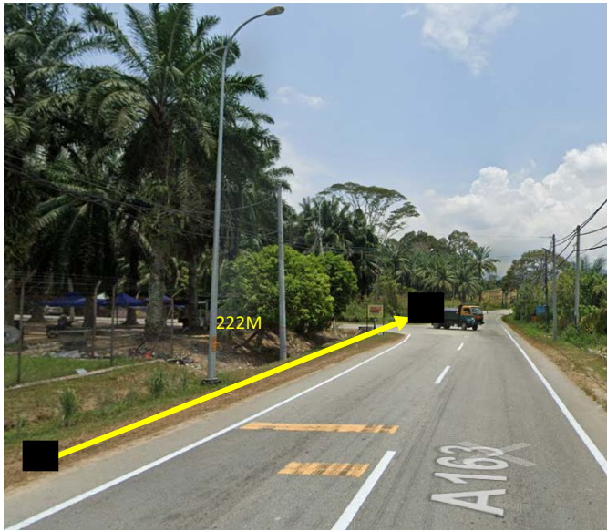
Gambar 7: Kerja kerja menarik kabel 96C UG MH to MH sedia ada (Tidak Berturap)
