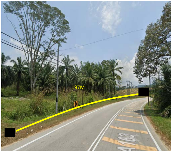
Gambar 8: Kerja kerja menarik kabel 96C UG MH to MH sedia ada (Tidak Berturap)
