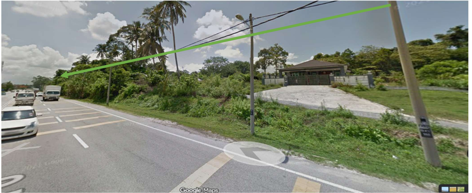
JALAN KAMPAR CHANGKAT JONG-KAEDAH TUMPANG TIANG SEHINGGA KE TIANG 13K5/170
