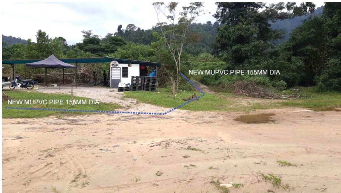
GAMBAR 7 : Kawasan cadangan laluan paip baru pada laluan tepi jalan.
