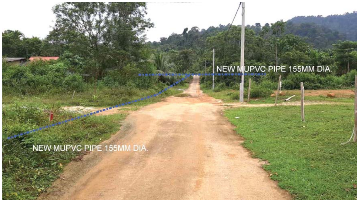
GAMBAR 6 : Kawasan cadangan laluan paip baru pada laluan tepi jalan.
