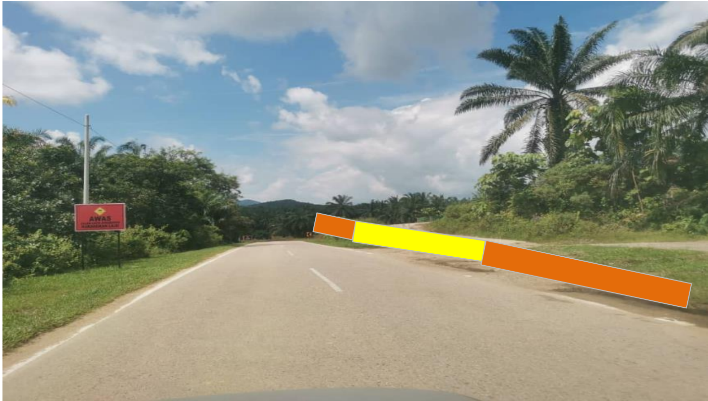
KAWASAN KERJA MELIBATKAN OPEN CUT DI ATAS JALAN TAR
