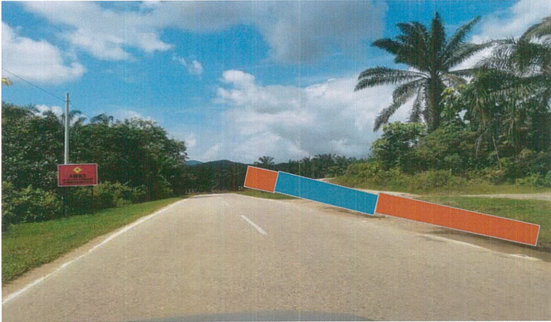
KAWASAN KERJA MELIBATKAN OPEN CUT DI ATAS JALAN TAR KAWASAN KERJA MELIBATKAN OPEN CUT DI ATAS TANAH BIASA
