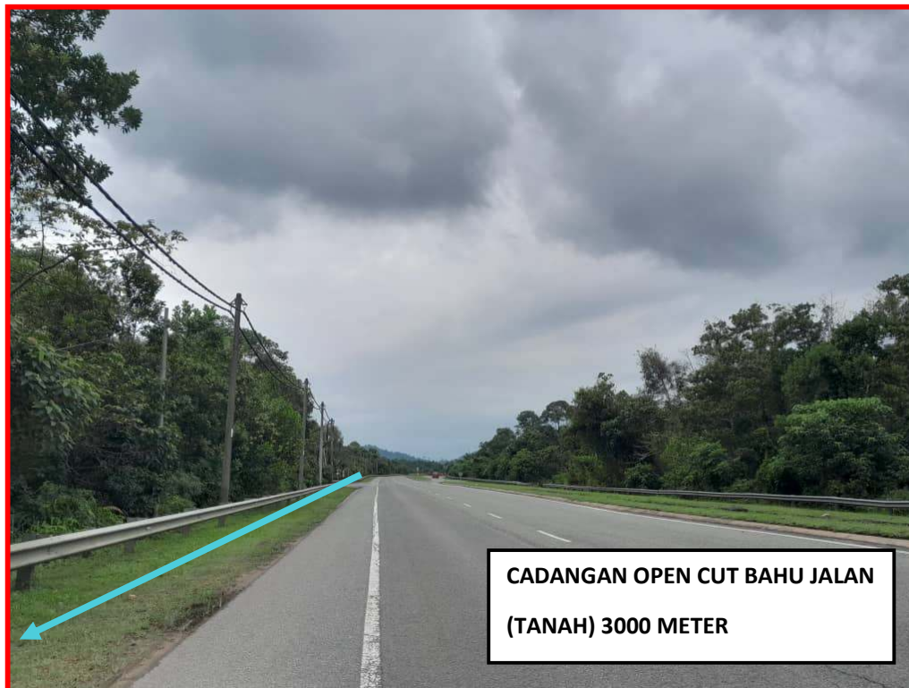
GAMBAR 3: KAWASAN KERJA MELIBATKAN KAEDAH OPEN CUT BAHU JALAN ( TANAH)
