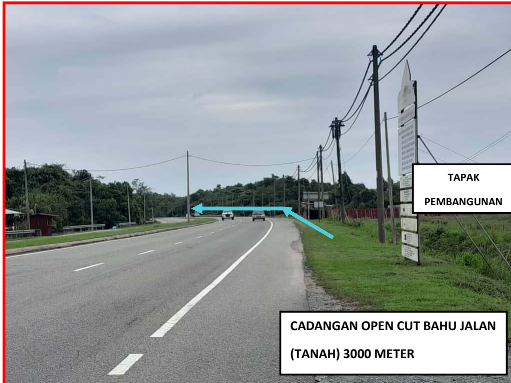
GAMBAR 1: KAWASAN KERJA MELIBATKAN KAEDAH OPEN CUT BAHU JALAN ( TANAH)
