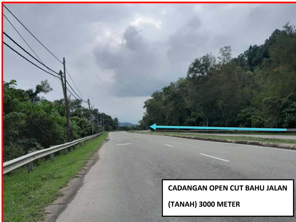
GAMBAR 2: KAWASAN KERJA MELIBATKAN KAEDAH OPEN CUT BAHU JALAN ( TANAH)
