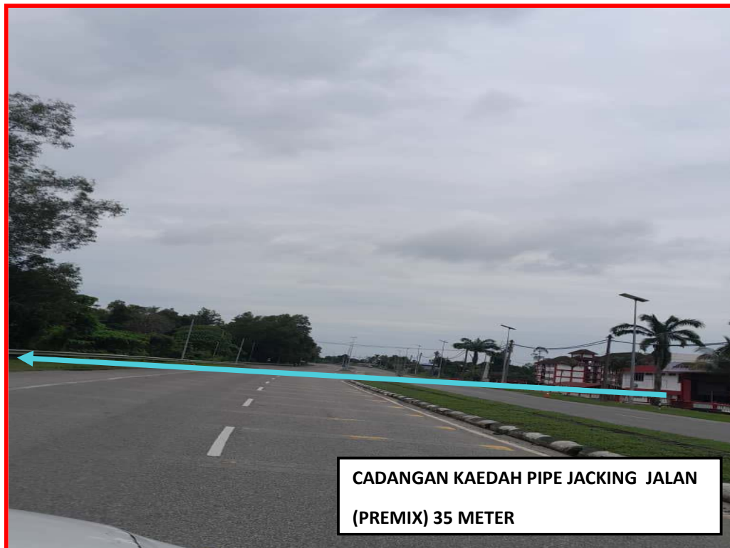
GAMBAR 8: KAWASAN KERJA MELIBATKAN KAEDAH PIPE JACKING ( BERTAR /PREMIX)
