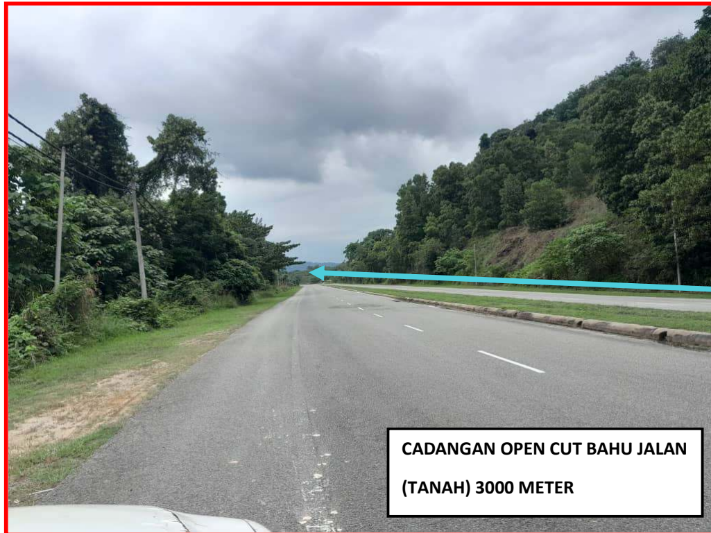
GAMBAR 7: KAWASAN KERJA MELIBATKAN KAEDAH OPEN CUT BAHU JALAN ( TANAH)
