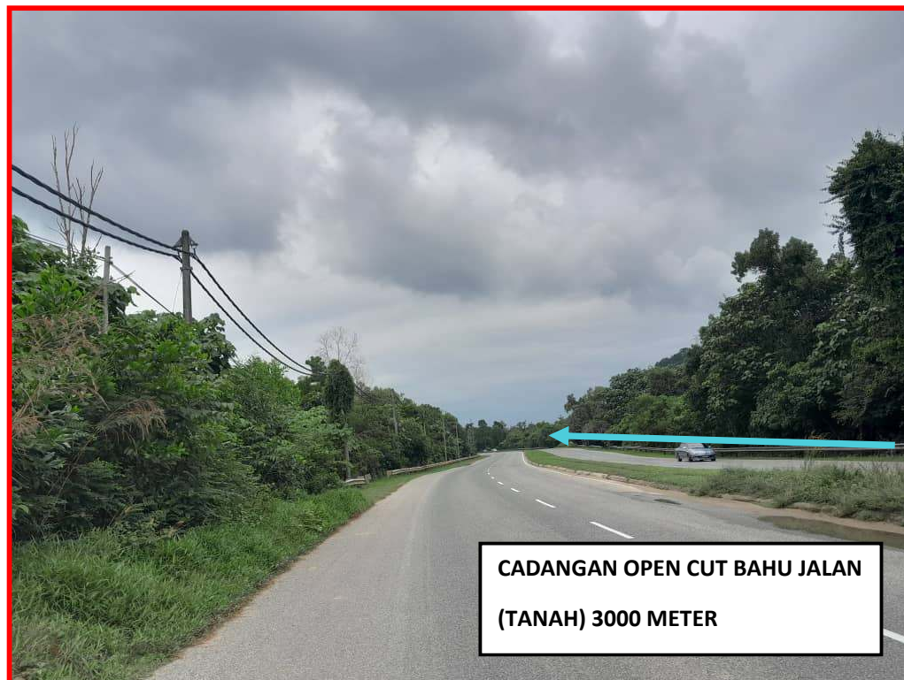
GAMBAR 6: KAWASAN KERJA MELIBATKAN KAEDAH OPEN CUT BAHU JALAN ( TANAH)
