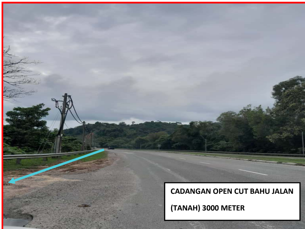
GAMBAR 4: KAWASAN KERJA MELIBATKAN KAEDAH OPEN CUT BAHU JALAN ( TANAH)
