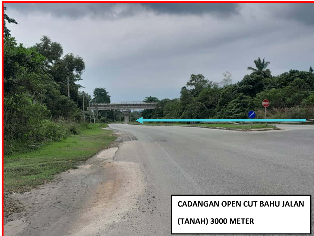
GAMBAR 5: KAWASAN KERJA MELIBATKAN KAEDAH OPEN CUT BAHU JALAN ( TANAH)
