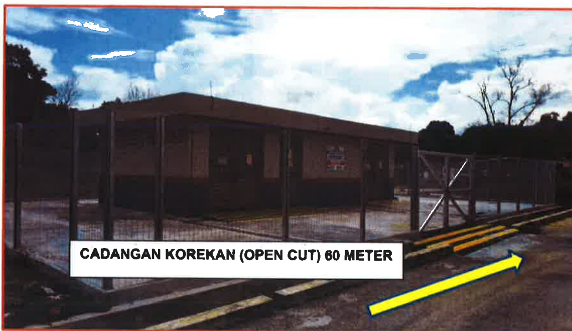
GAMBAR 11 : KAWASAN KERJA MELIBATKAN PEMOTONGAN JALAN (OPEN CUT)
