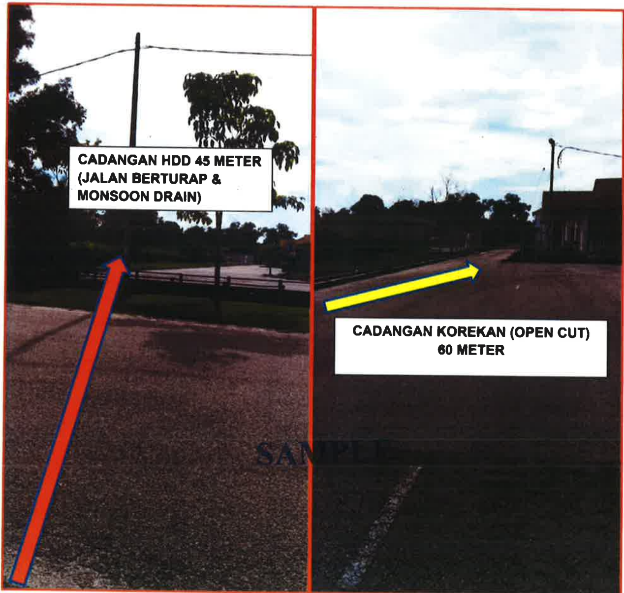
GAMBAR 9 : KAWASAN KERJA MELIBATKAN 'HORIZONTAL DIRECTIONAL DRILLING'
