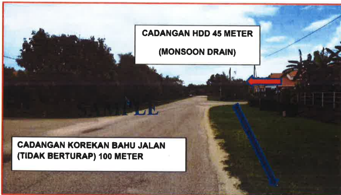
GAMBAR 5 : KAWASAN KERJA MELIBATKAN PEMOTONGAN BAHU JALAN (TIDAK BERTURAP)
