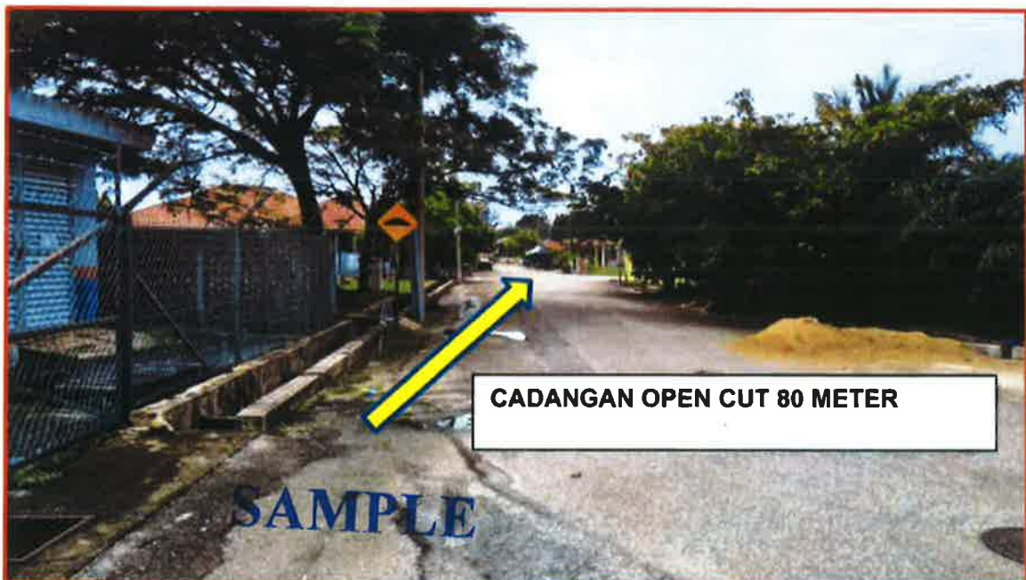
GAMBAR 2 : KAWASAN KERJA MELIBATKAN PEMOTONGAN JALAN (OPEN CUT)
