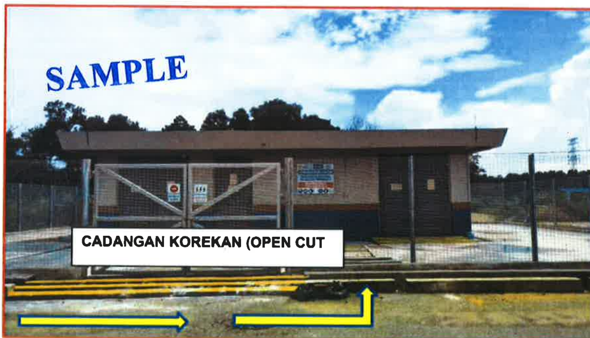
GAMBAR 12 : PENCAWANG BARU (PENCAWANG BALOK PERDANA 3)
