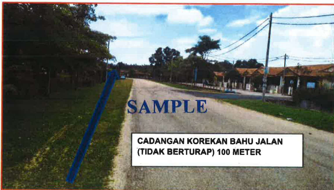
GAMBAR 6 : KAWASAN KERJA MELIBATKAN PEMOTONGAN BAHU JALAN (TIDAK BERTURAP)
