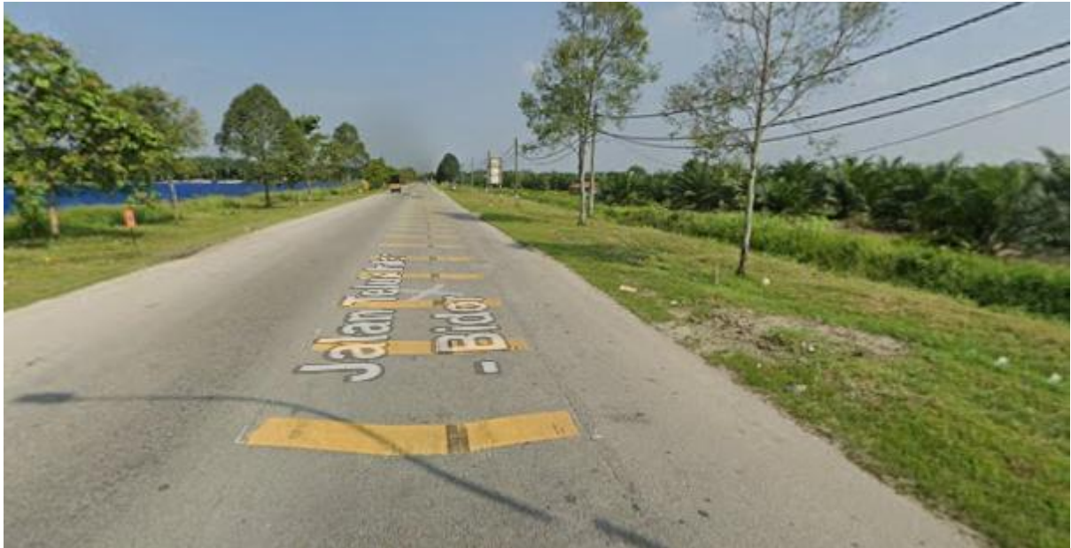
Jalan Teluk Intan – Bidor. 1300m korekan HDD
