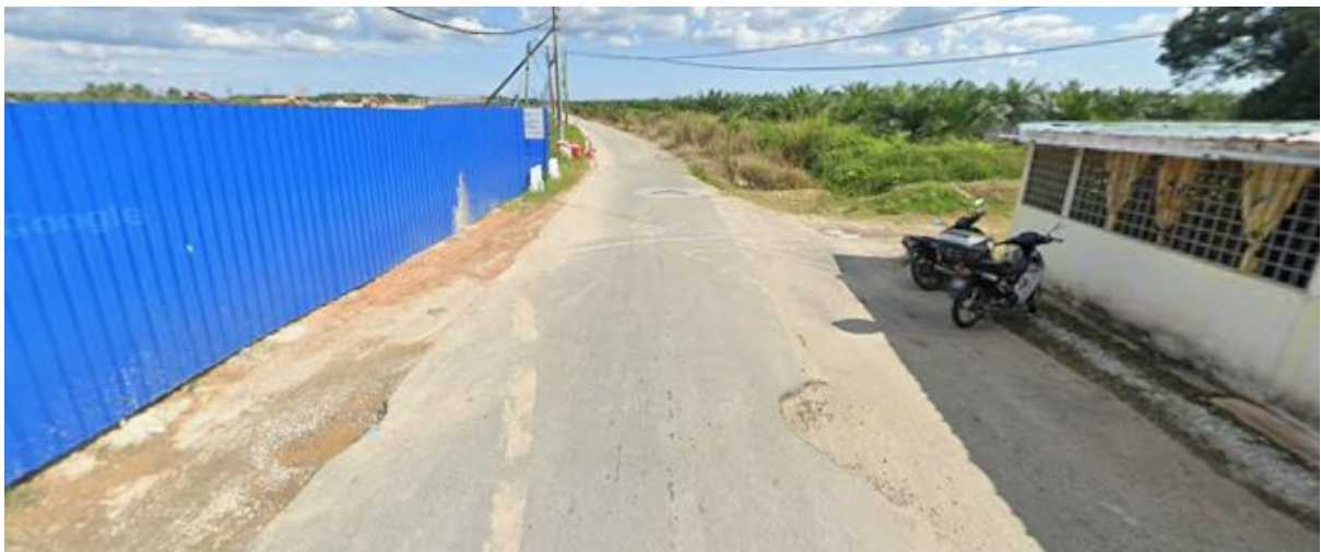
Jalan masuk ke Kampung Selabak dari jalan JKR. Korekan Open Cut
