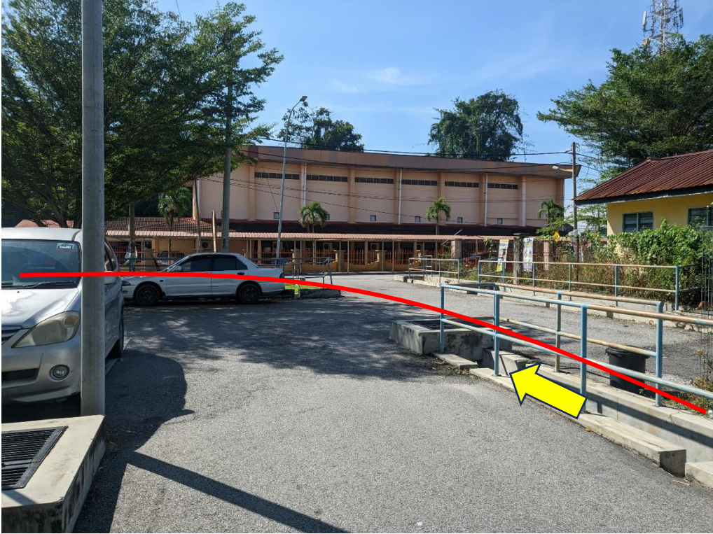
GAMBAR 3: KAWASAN KERJA MELIBATKAN 'HORIZONTAL DIRECTIONAL DRILLING'
