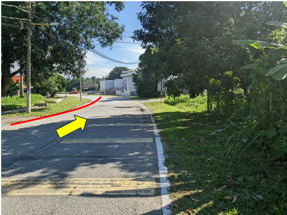
GAMBAR 4: KAWASAN KERJA MELIBATKAN 'HORIZONTAL DIRECTIONAL DRILLING'
