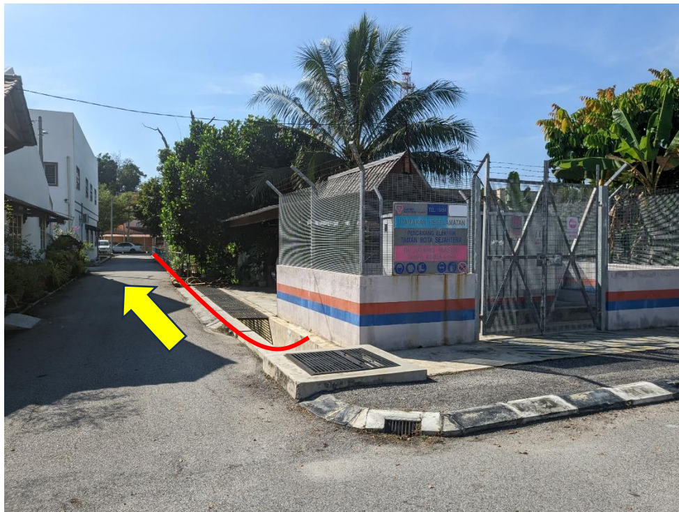
GAMBAR 2: KAWASAN KERJA MELIBATKAN 'HORIZONTAL DIRECTIONAL DRILLING'
