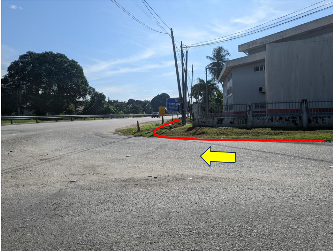
GAMBAR 5: KAWASAN KERJA MELIBATKAN 'HORIZONTAL DIRECTIONAL DRILLING'
