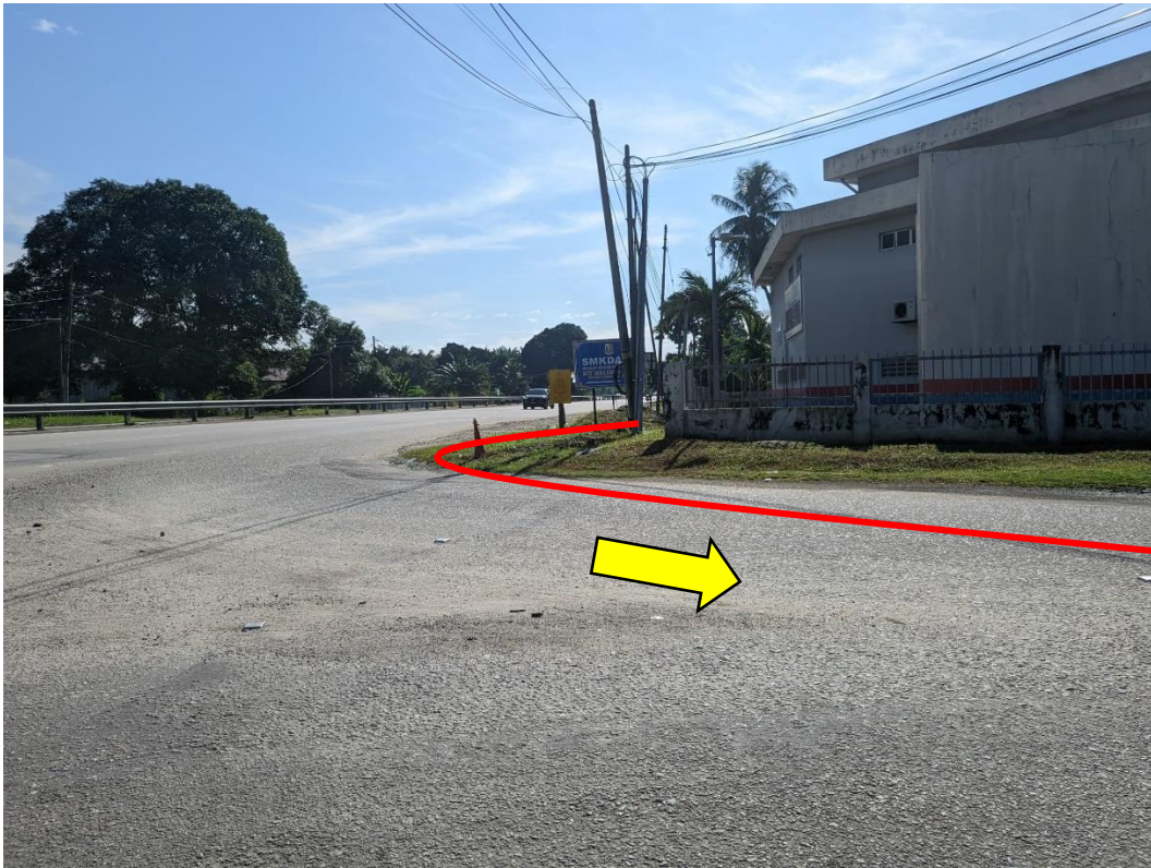
GAMBAR 1: KAWASAN KERJA MELIBATKAN 'HORIZONTAL DIRECTIONAL DRILLING'
