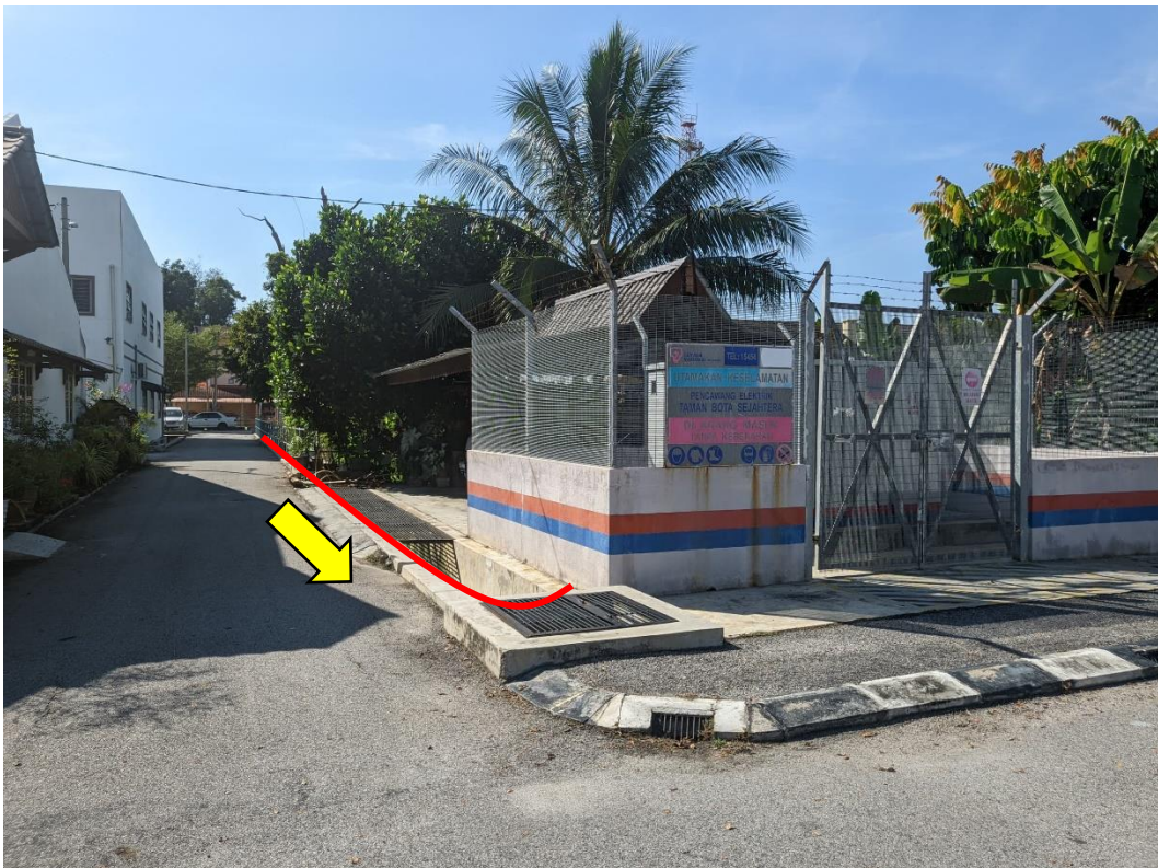
GAMBAR 4: KAWASAN KERJA MELIBATKAN 'HORIZONTAL DIRECTIONAL DRILLING'
