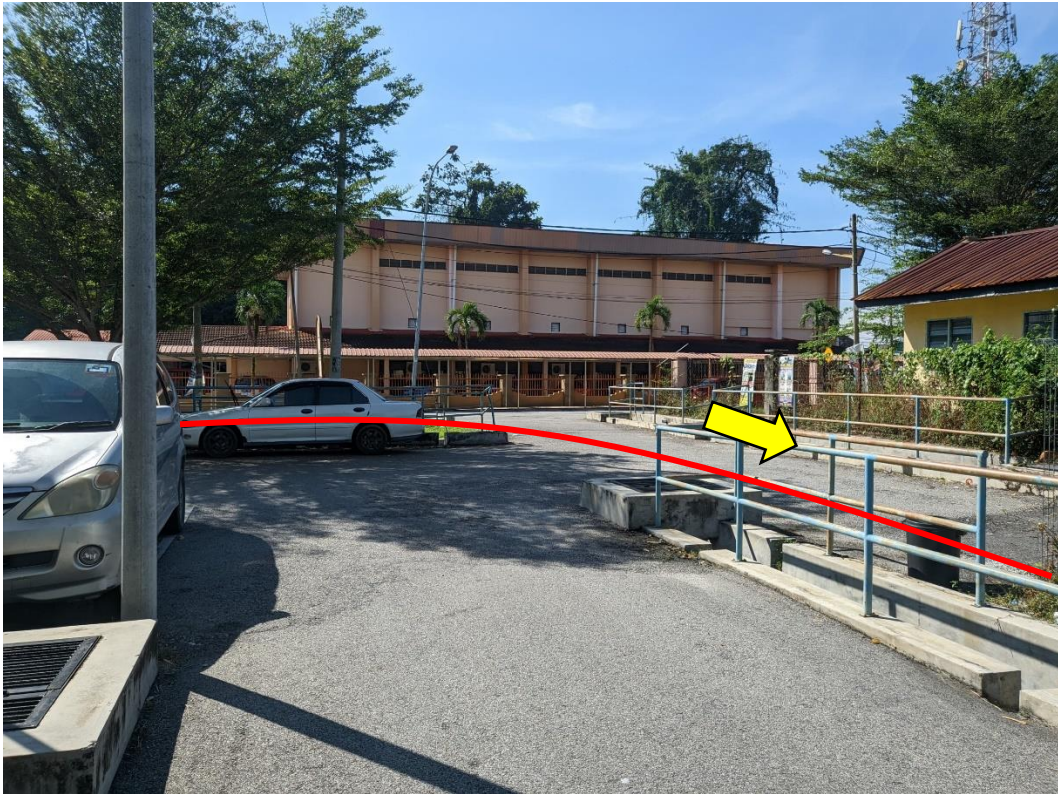
GAMBAR 3: KAWASAN KERJA MELIBATKAN 'HORIZONTAL DIRECTIONAL DRILLING'
