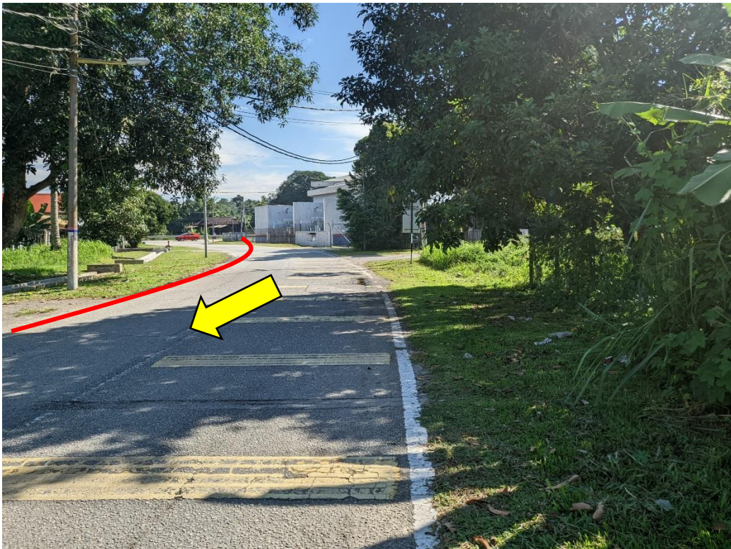
GAMBAR 2: KAWASAN KERJA MELIBATKAN 'HORIZONTAL DIRECTIONAL DRILLING'
