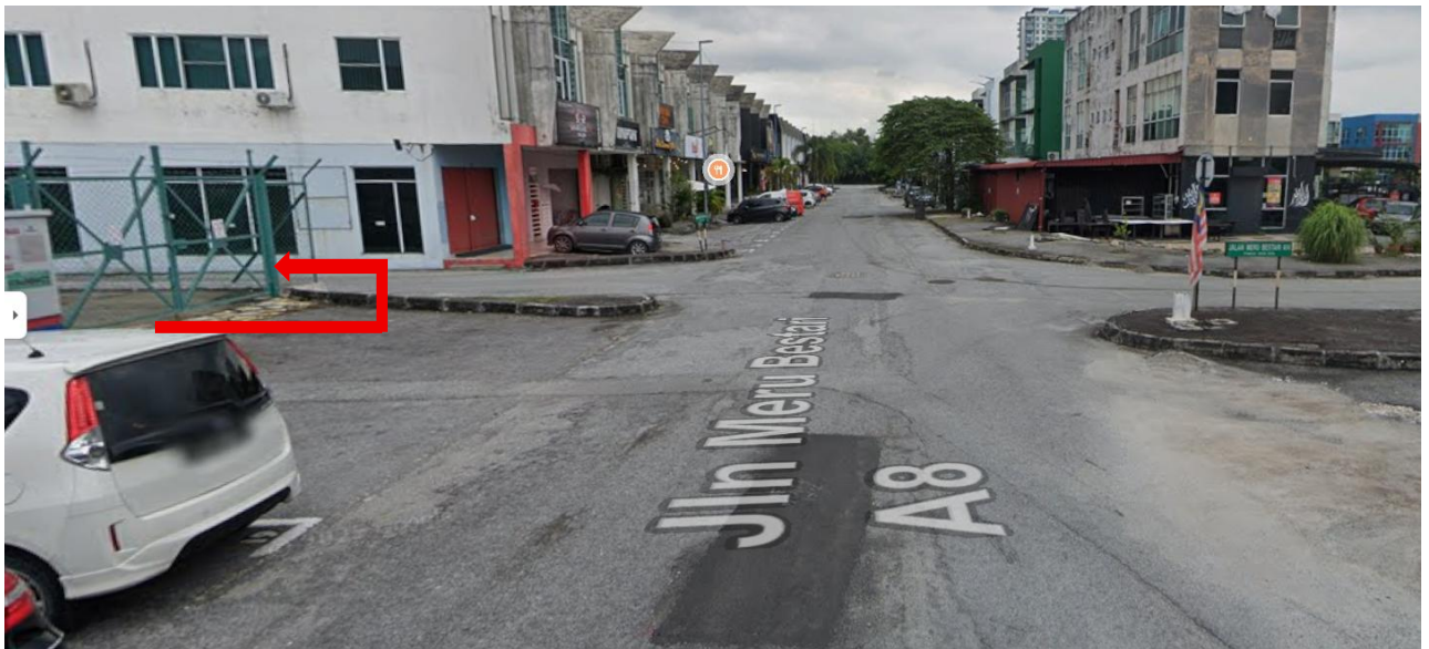
Gambar 2: Kawasan Kerja Melibatkan Pemotongan Jalan ( Open Cut )
