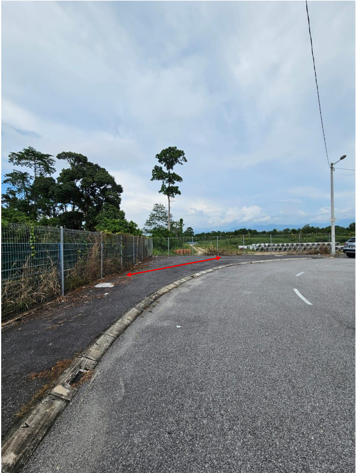
GAMBAR 2: KAWASAN KERJA MELIBATKAN OPEN CUT ATAS JALAN BERTURAP
