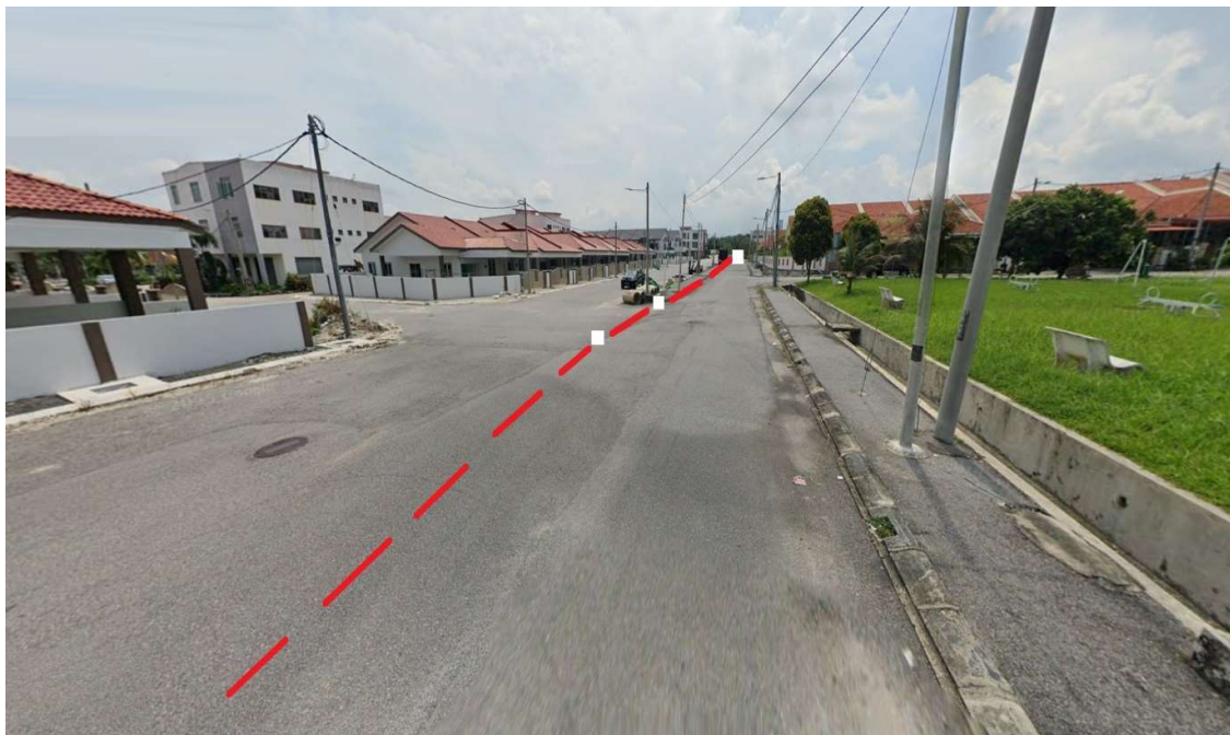
Gambar 2 : KAWASAN KERJA MELIBATKAN PEMOTONGAN JALAN (OPEN CUT)
