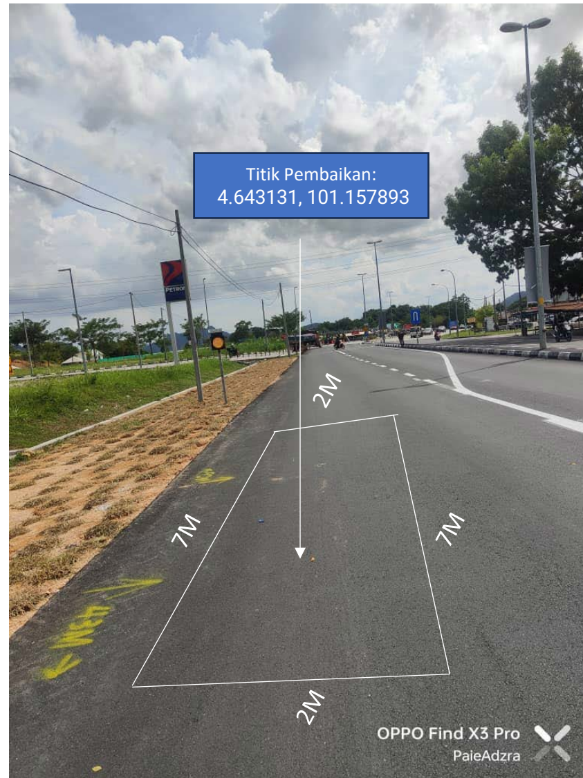
GAMBAR 2: LOKASI PEMBAIKKAN MELIBATKAN KAWASAN PENANDAAN KOTAK DIATAS (KERJA-KERJA KOREKKAN DAN TURAPAN SEMULA AKAN DIBUAT)
