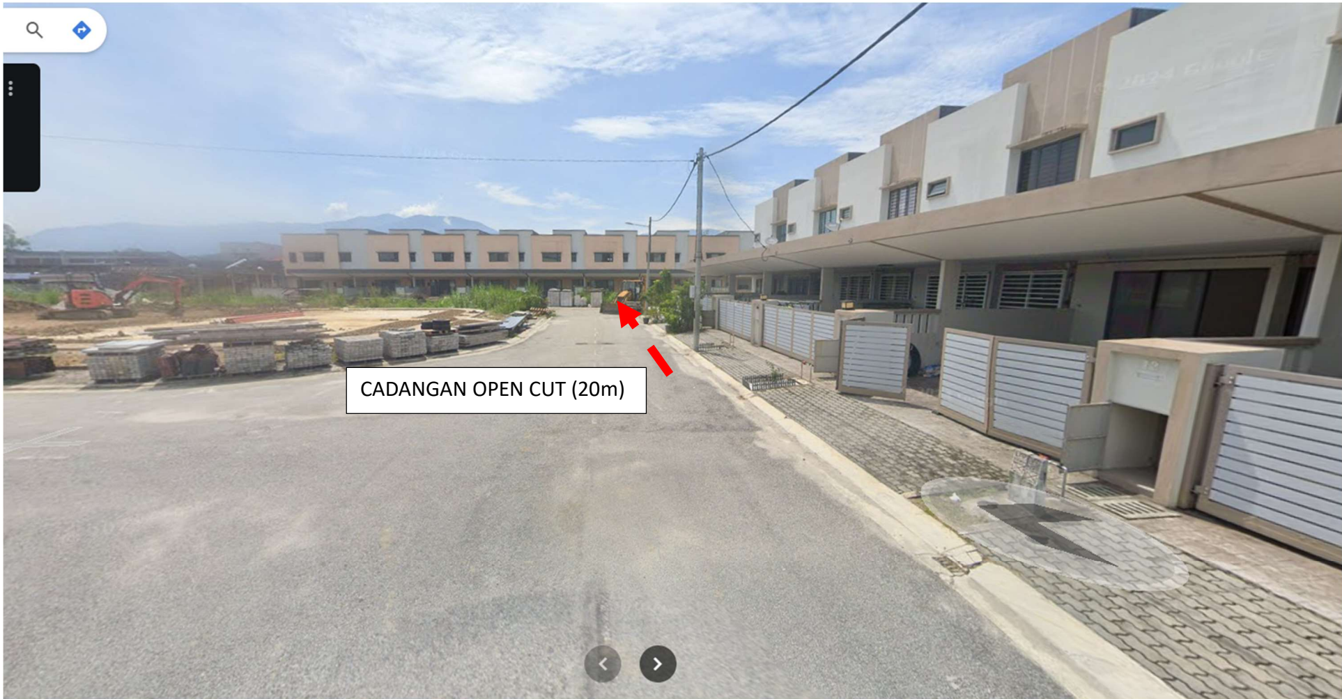
GAMBAR 7: KAWASAN MELIBATKAN PEMOTONGAN JALAN (OPEN CUT) JALAN PELANGI 6
