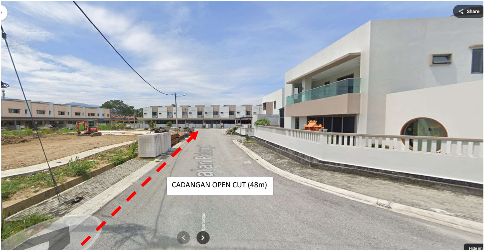
GAMBAR 6: KAWASAN MELIBATKAN PEMOTONGAN JALAN (OPEN CUT) JALAN PELANGI 6
