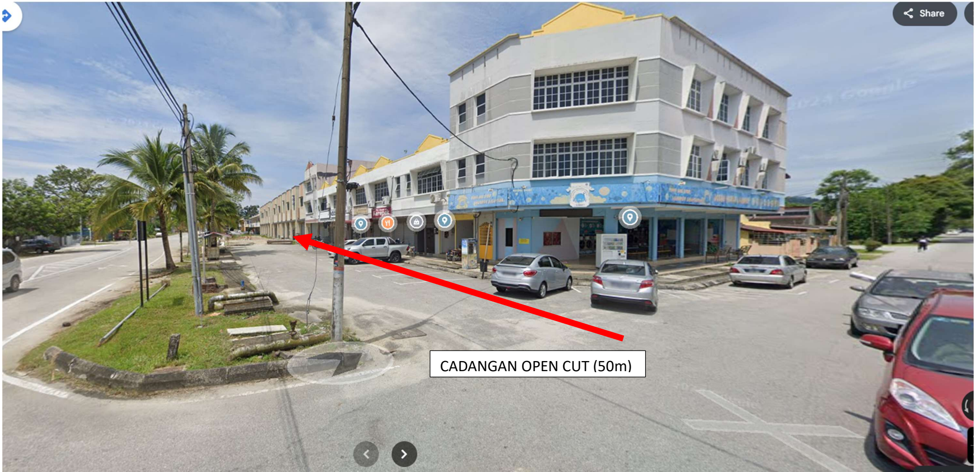
GAMBAR 4: KAWASAN MELIBATKAN PEMOTONGAN JALAN (OPEN CUT) JALAN INDAH 1
