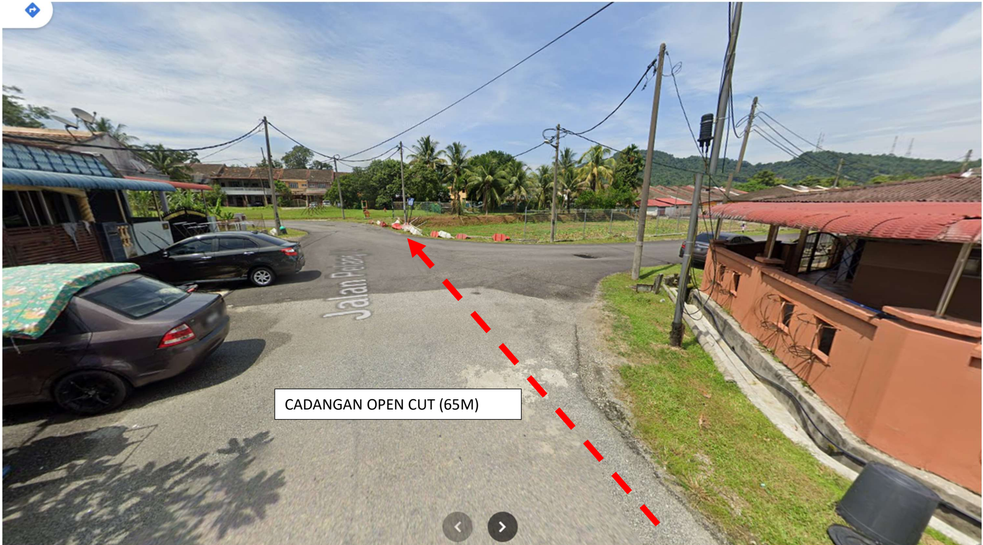
GAMBAR 8: KAWASAN MELIBATKAN PEMOTONGAN JALAN (OPEN CUT) JALAN PELANGI 3
