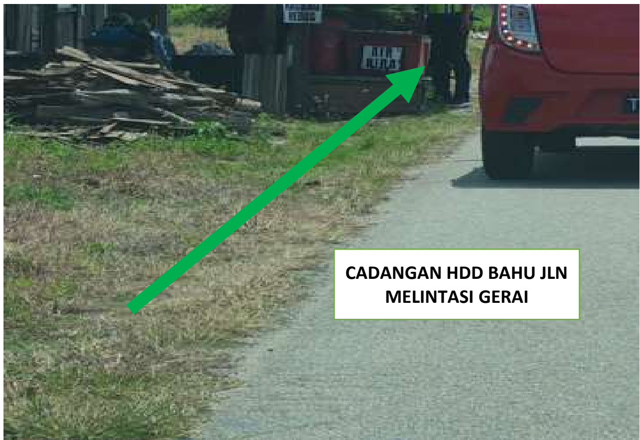
GAMBAR 9 : KAWASAN KERJA MELIBATKAN 'HORIZONTAL DIRECTIONAL DRILLING' (HDD)
