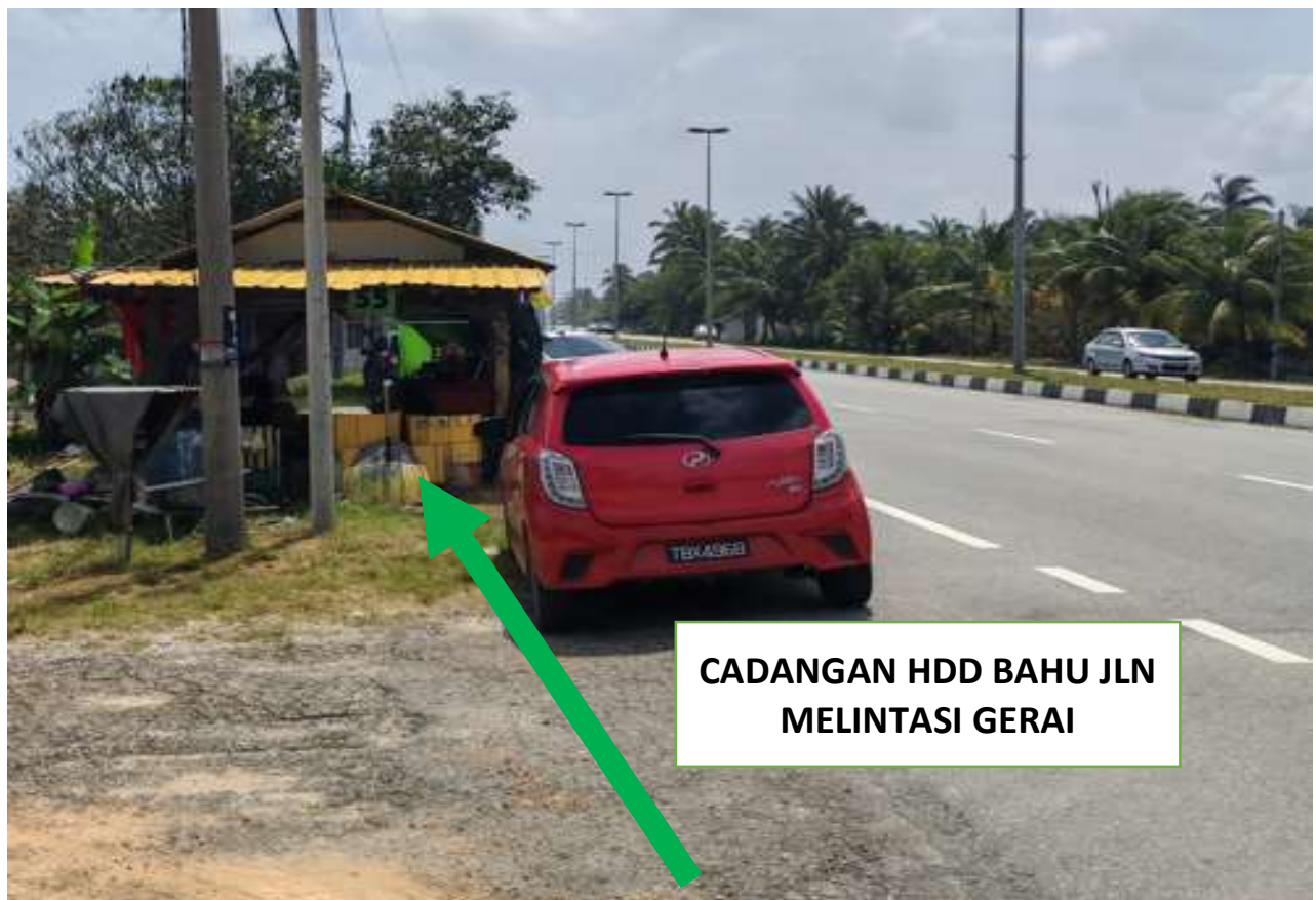
GAMBAR 3 : KAWASAN KERJA MELIBATKAN 'HORIZONTAL DIRECTIONAL DRILLING' (HDD)
