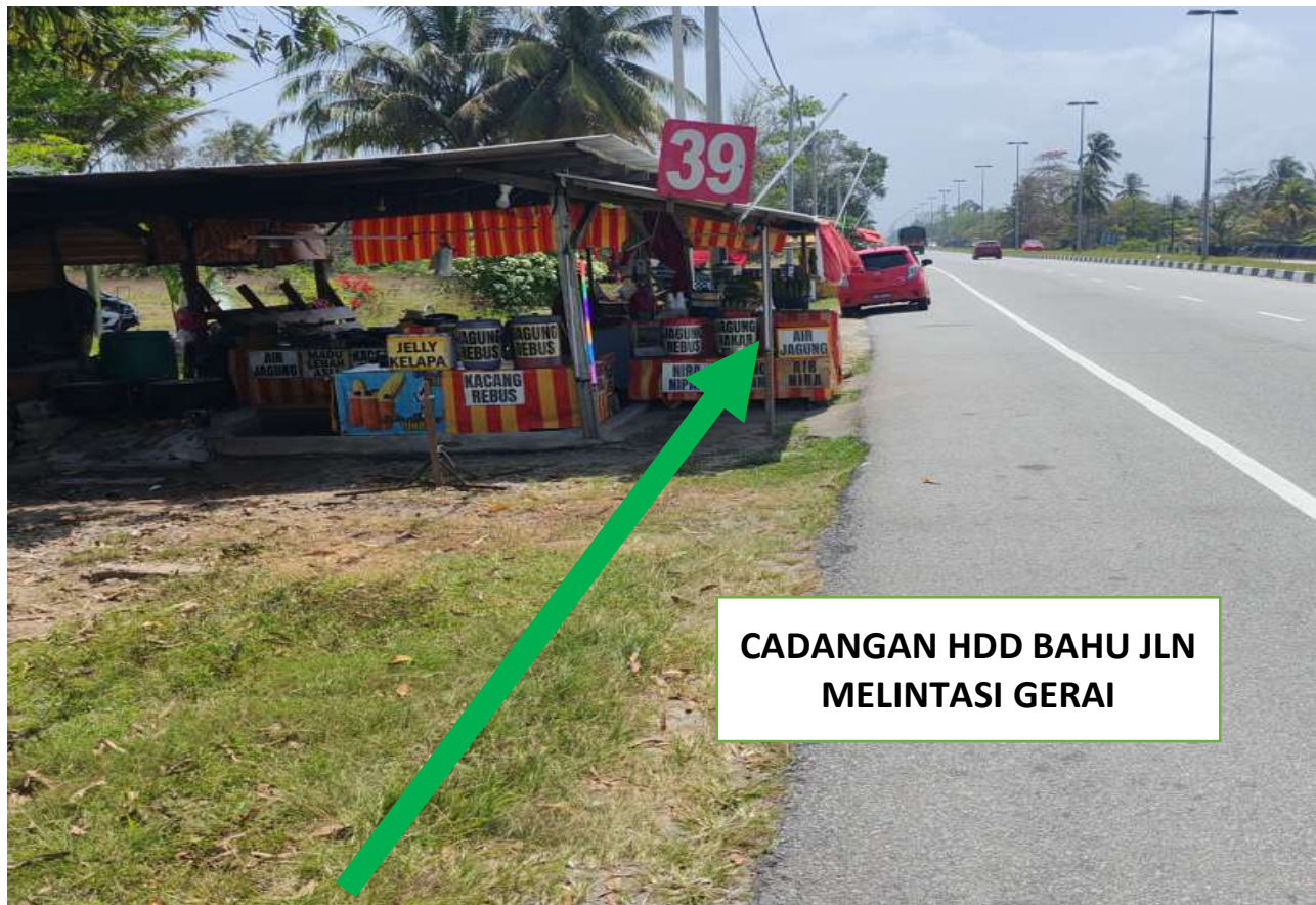
GAMBAR 5 : KAWASAN KERJA MELIBATKAN 'HORIZONTAL DIRECTIONAL DRILLING' (HDD)
