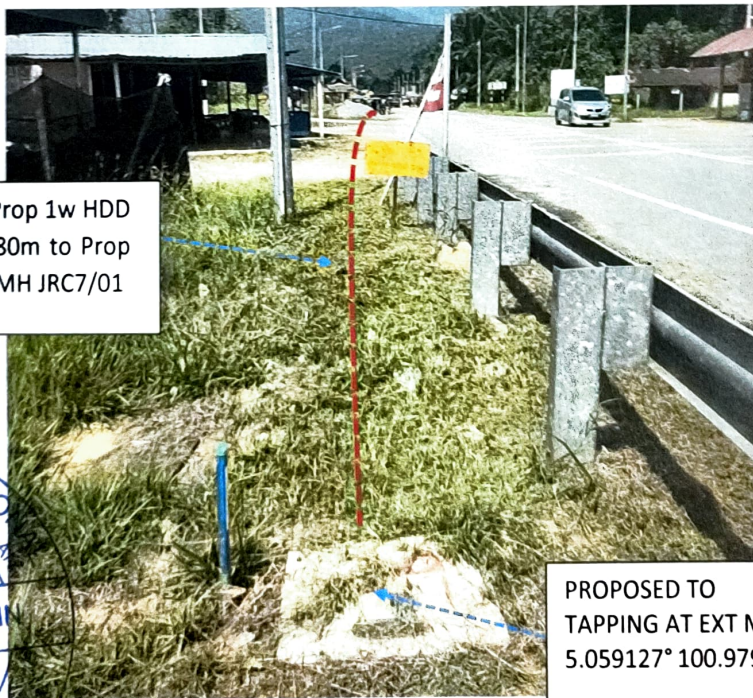
FDC01 LOCATION AT JALAN KOTA TAMPAM
