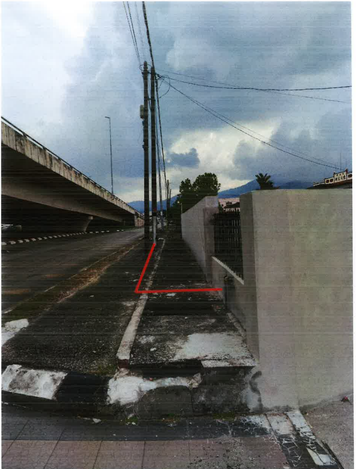
Rentang kabel bawah tanah sepanjang (30 meter)
