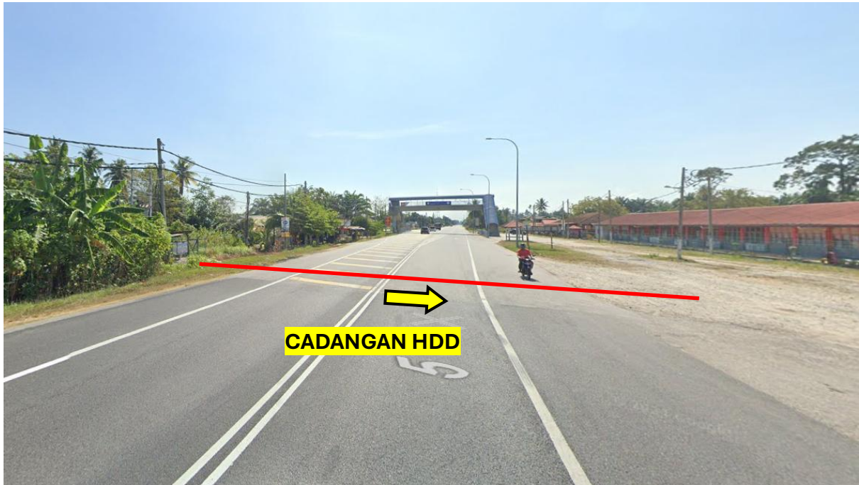
GAMBAR 1: KAWASAN KERJA MELIBATKAN 'HORIZONTAL DIRECTIONAL DRILLING'
