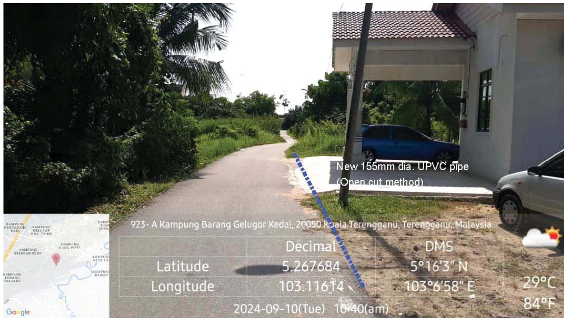
GAMBAR 4 : Kawasan cadangan laluan paip baru pada laluan jalan.
