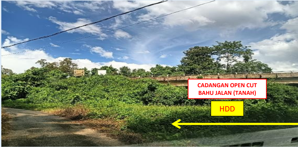
GAMBAR 1 : KAWASAN KERJA MELIBATKAN PEMOTONGAN BAHU JALAN (BERTANAH)
