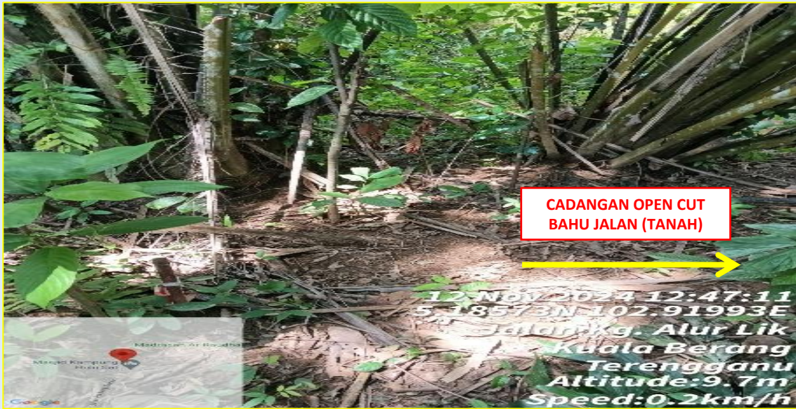
GAMBAR 3 : KAWASAN KERJA MELIBATKAN PEMOTONGAN BAHU JALAN (BERTANAH)
