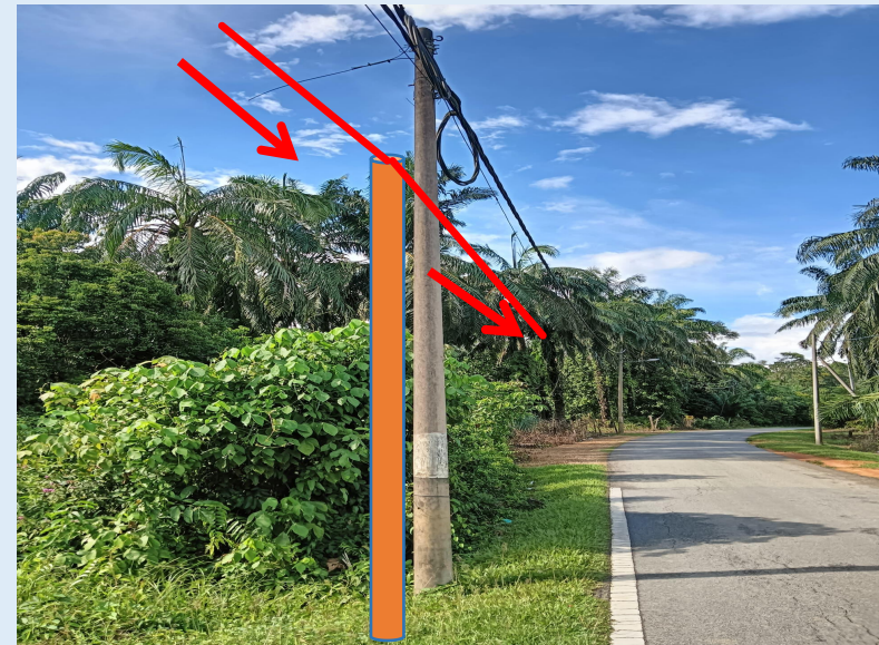
GAMBAR 18 : KAWASAN KERJA MELIBATKAN TANAM TIANG 7.5M (BERTANAH)
