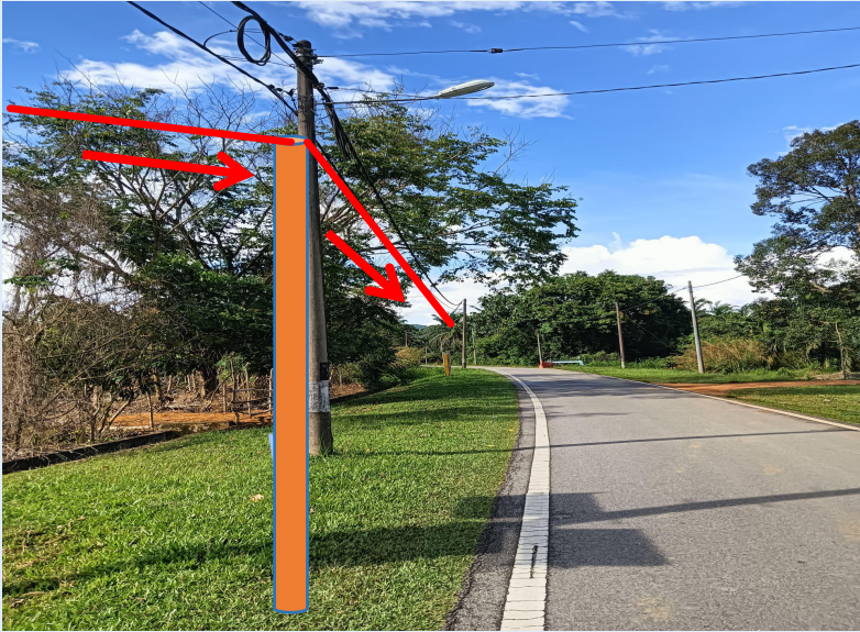
GAMBAR 15 : KAWASAN KERJA MELIBATKAN TANAM TIANG 7.5M (BERTANAH)
