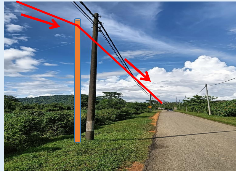
GAMBAR 22 : KAWASAN KERJA MELIBATKAN TANAM TIANG 7.5M (BERTANAH)
