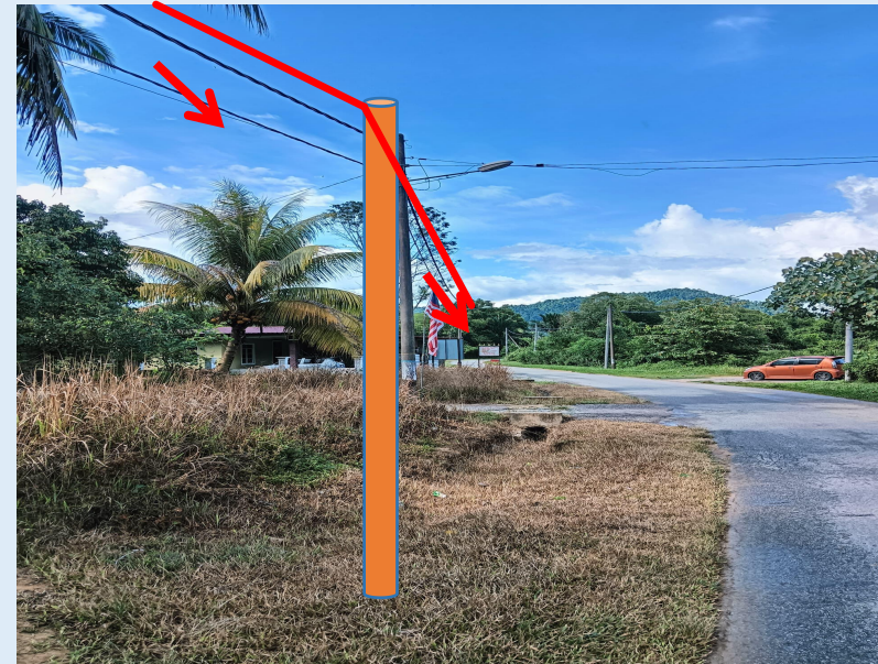
GAMBAR 20 : KAWASAN KERJA MELIBATKAN TANAM TIANG 7.5M (BERTANAH)
