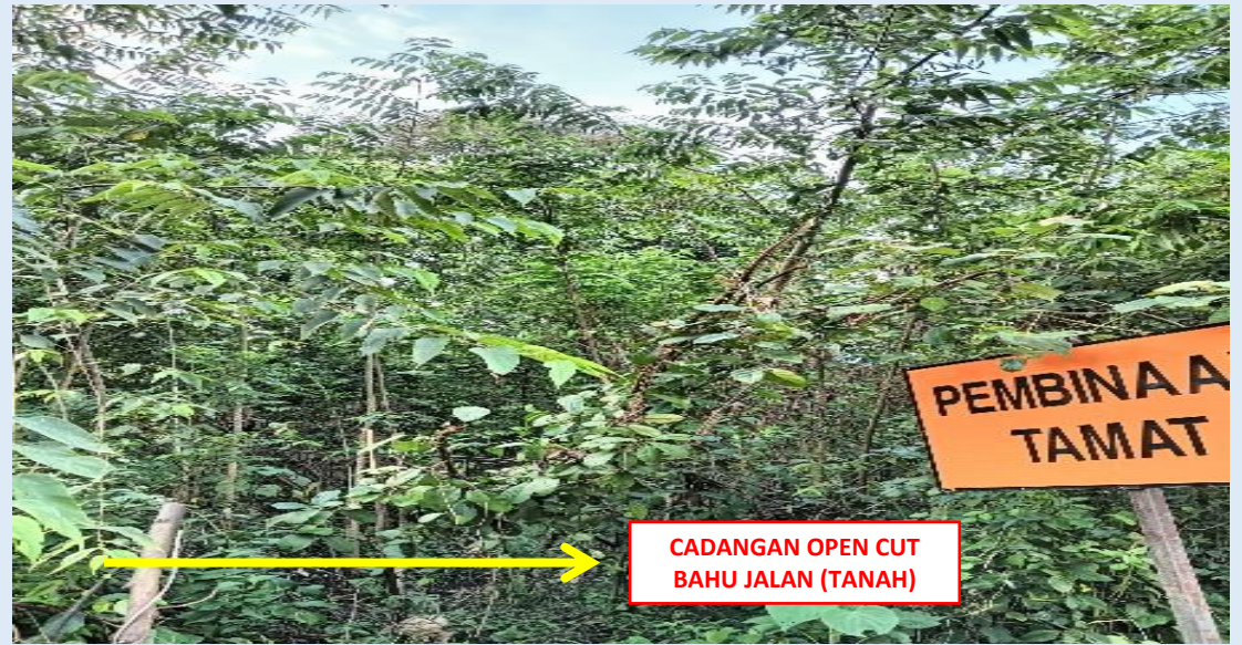
GAMBAR 4 : KAWASAN KERJA MELIBATKAN PEMOTONGAN BAHU JALAN (BERTANAH)
