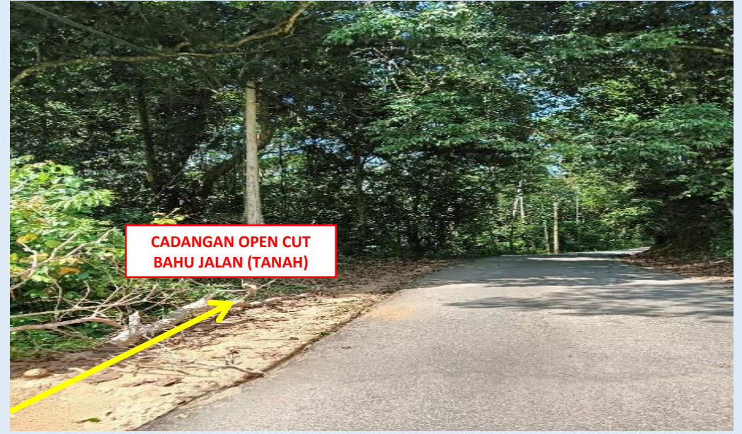
GAMBAR 6 : KAWASAN KERJA MELIBATKAN PEMOTONGAN BAHU JALAN (BERTANAH)
