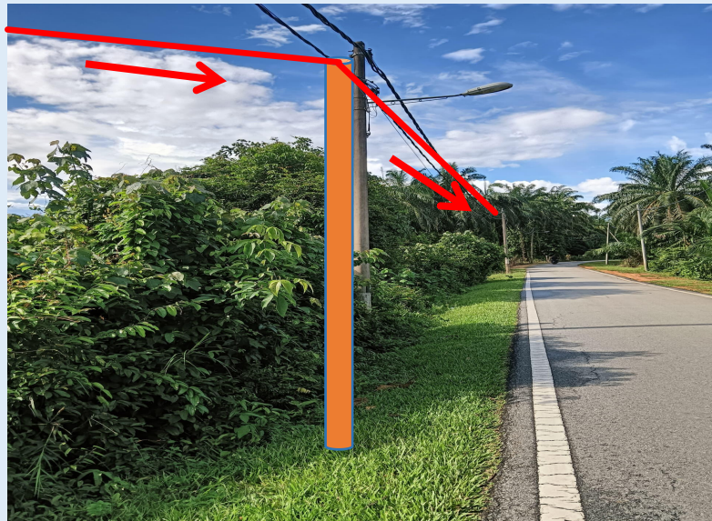
GAMBAR 17 : KAWASAN KERJA MELIBATKAN TANAM TIANG 7.5M (BERTANAH)
