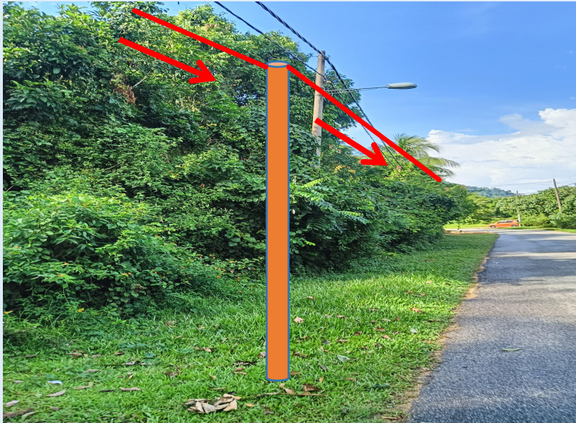
GAMBAR 19 : KAWASAN KERJA MELIBATKAN TANAM TIANG 7.5M (BERTANAH)
