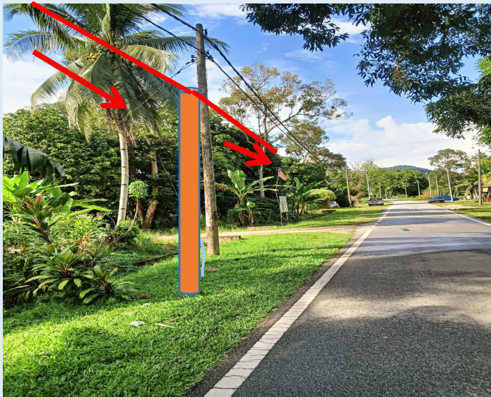
GAMBAR 13 : KAWASAN KERJA MELIBATKAN TANAM TIANG 7.5M (BERTANAH)
