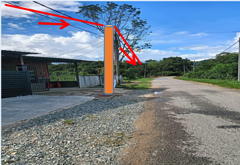
GAMBAR 21 : KAWASAN KERJA MELIBATKAN TANAM TIANG 7.5M (BERTANAH)
