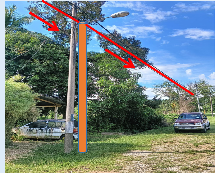
GAMBAR 14 : KAWASAN KERJA MELIBATKAN TANAM TIANG 7.5M (BERTANAH)
