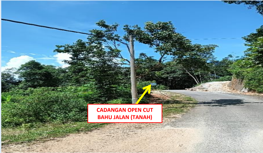
GAMBAR 5 : KAWASAN KERJA MELIBATKAN PEMOTONGAN BAHU JALAN (BERTANAH)
