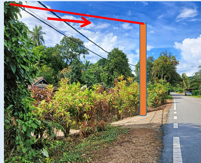
GAMBAR 10 : KAWASAN KERJA MELIBATKAN TANAM TIANG 7.5M (BERTANAH)
