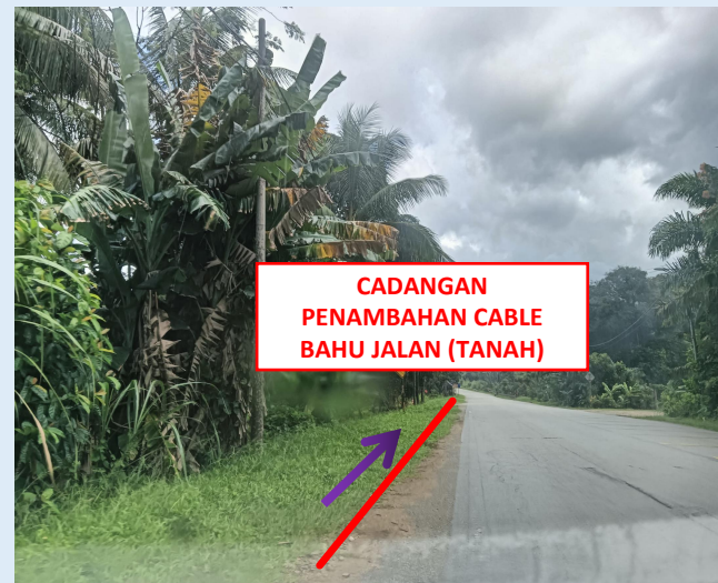
GAMBAR 26 : KAWASAN KERJA MELIBATKAN LALUAN CABLE (BERTANAH)
