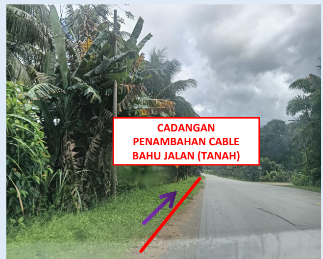
GAMBAR 26 : KAWASAN KERJA MELIBATKAN LALUAN CABLE (BERTANAH)
