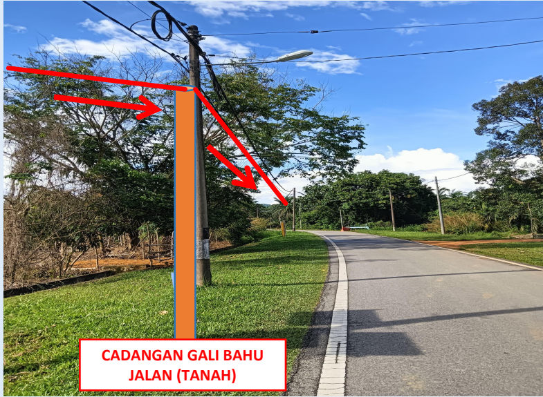
GAMBAR 15 : KAWASAN KERJA MELIBATKAN TANAM TIANG 7.5M (BERTANAH)
