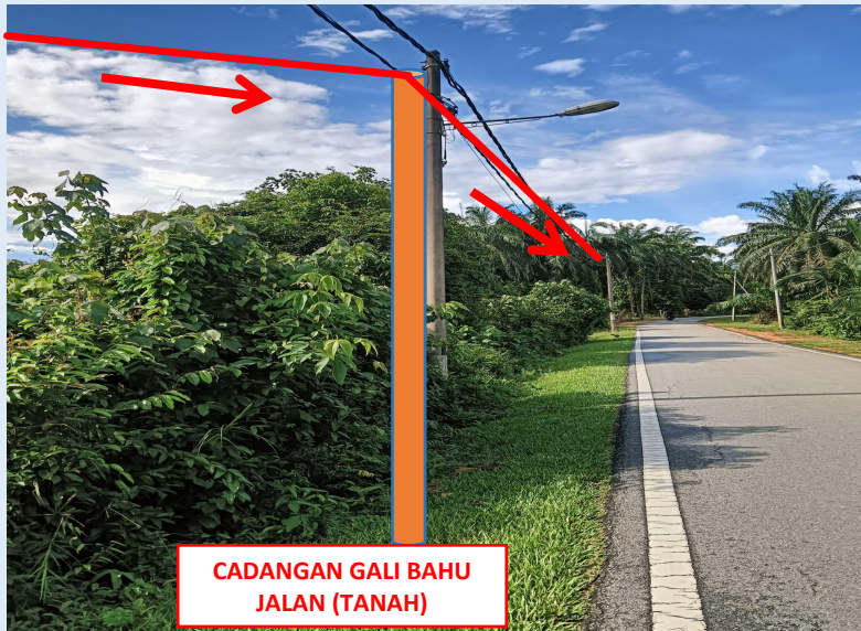
GAMBAR 17 : KAWASAN KERJA MELIBATKAN TANAM TIANG 7.5M (BERTANAH)
