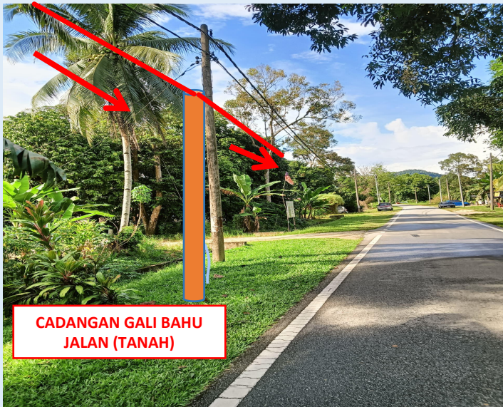
GAMBAR 11 : KAWASAN KERJA MELIBATKAN TANAM TIANG 7.5M (BERTANAH)
