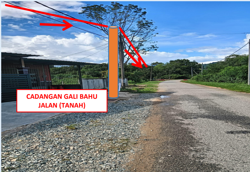
GAMBAR 21 : KAWASAN KERJA MELIBATKAN TANAM TIANG 7.5M (BERTANAH)
