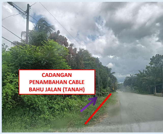
GAMBAR 25 : KAWASAN KERJA MELIBATKAN LALUAN CABLE (BERTANAH)
