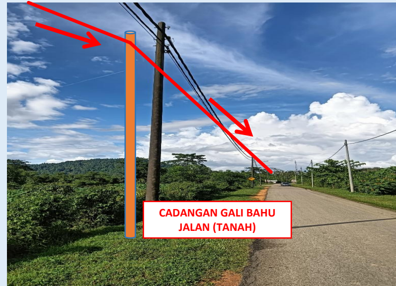
GAMBAR 22 : KAWASAN KERJA MELIBATKAN TANAM TIANG 7.5M (BERTANAH)
