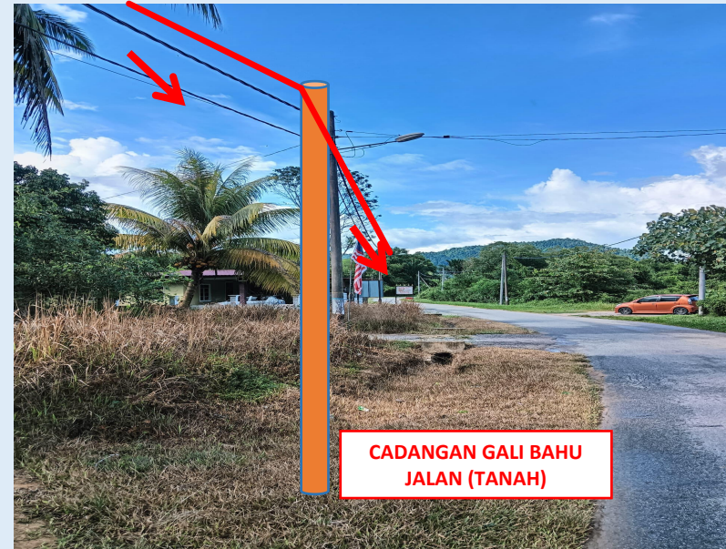
GAMBAR 20 : KAWASAN KERJA MELIBATKAN TANAM TIANG 7.5M (BERTANAH)
