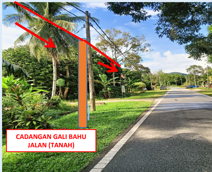
GAMBAR 11 : KAWASAN KERJA MELIBATKAN TANAM TIANG 7.5M (BERTANAH)
