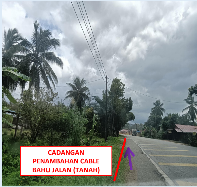
GAMBAR 23 : KAWASAN KERJA MELIBATKAN LALUAN CABLE (BERTANAH)
