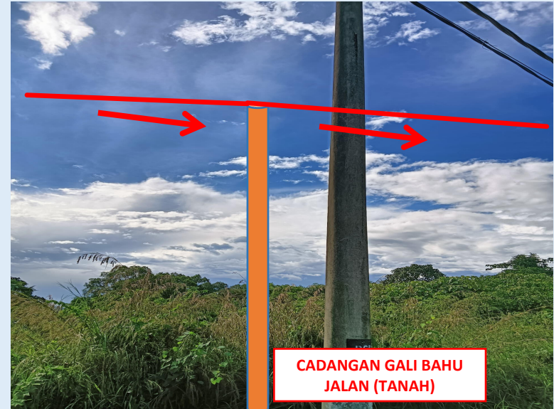
GAMBAR 16 : KAWASAN KERJA MELIBATKAN TANAM TIANG 7.5M (BERTANAH)
