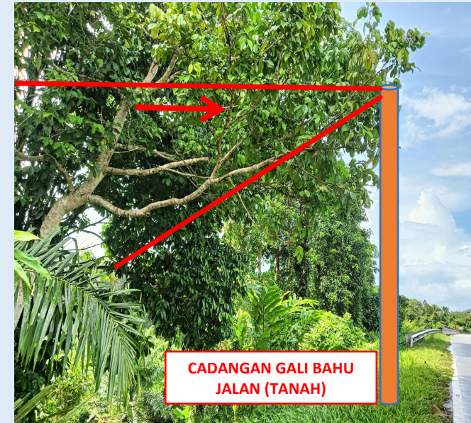
GAMBAR 8 : KAWASAN KERJA MELIBATKAN TANAM TIANG 7.5M (BERTANAH)
