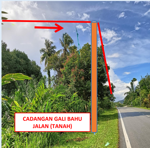
GAMBAR 7 : KAWASAN KERJA MELIBATKAN TANAM TIANG 7.5M (BERTANAH)
