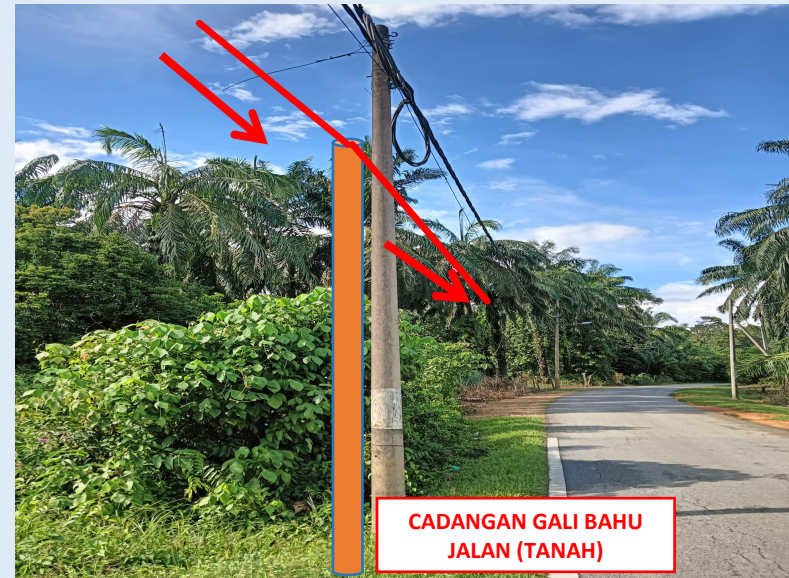
GAMBAR 18 : KAWASAN KERJA MELIBATKAN TANAM TIANG 7.5M (BERTANAH)
