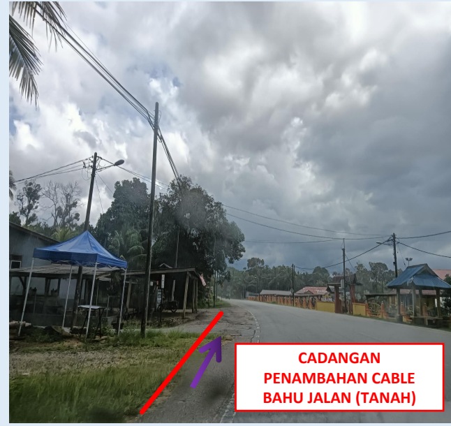
GAMBAR 24 : KAWASAN KERJA MELIBATKAN LALUAN CABLE (BERTANAH)
