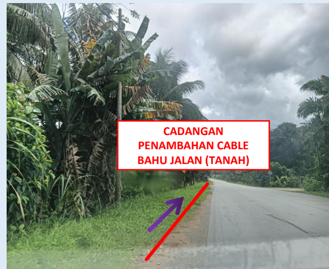
GAMBAR 26 : KAWASAN KERJA MELIBATKAN LALUAN CABLE (BERTANAH)
