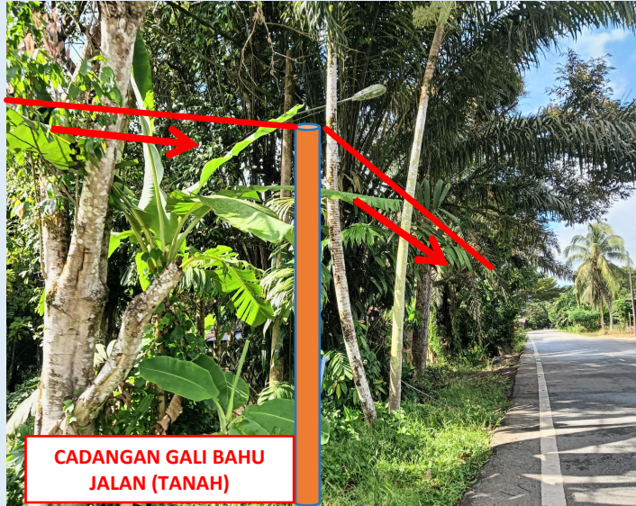
GAMBAR 11 : KAWASAN KERJA MELIBATKAN TANAM TIANG 7.5M (BERTANAH)
