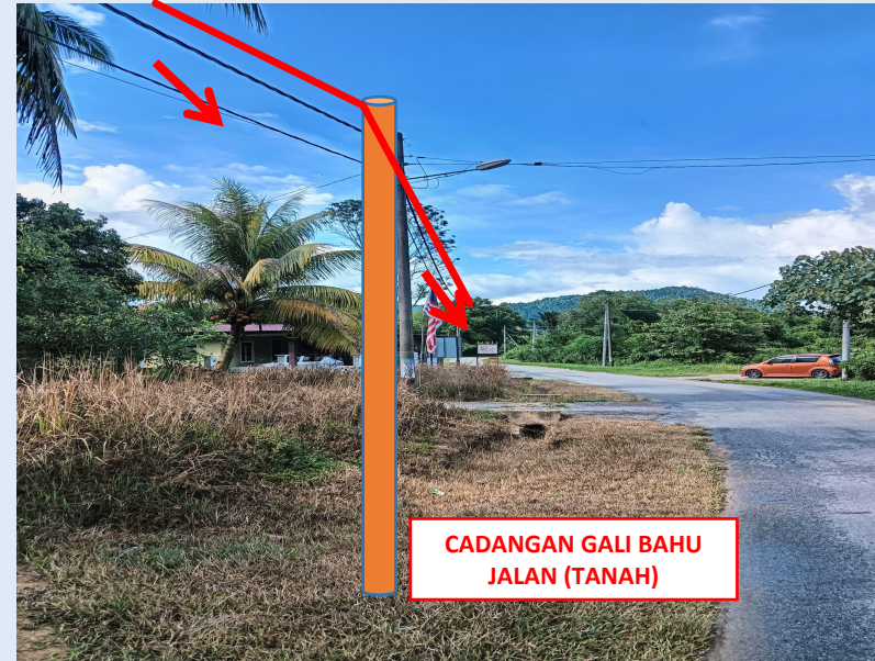
GAMBAR 20 : KAWASAN KERJA MELIBATKAN TANAM TIANG 7.5M (BERTANAH)
