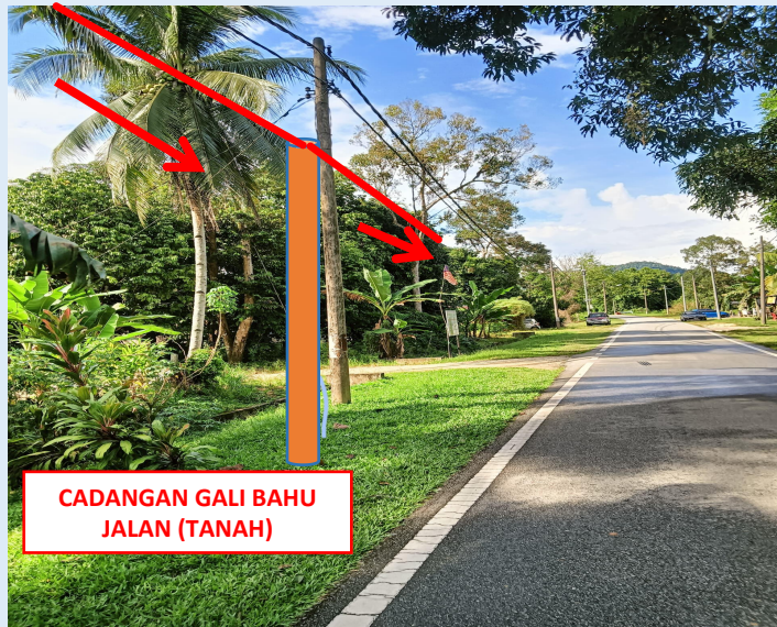
GAMBAR 11 : KAWASAN KERJA MELIBATKAN TANAM TIANG 7.5M (BERTANAH)
