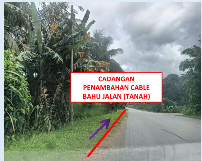
GAMBAR 26 : KAWASAN KERJA MELIBATKAN LALUAN CABLE (BERTANAH)
