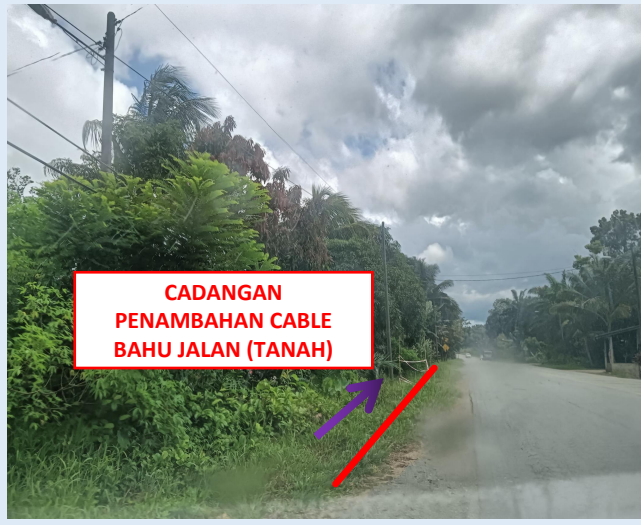
GAMBAR 25 : KAWASAN KERJA MELIBATKAN LALUAN CABLE (BERTANAH)
