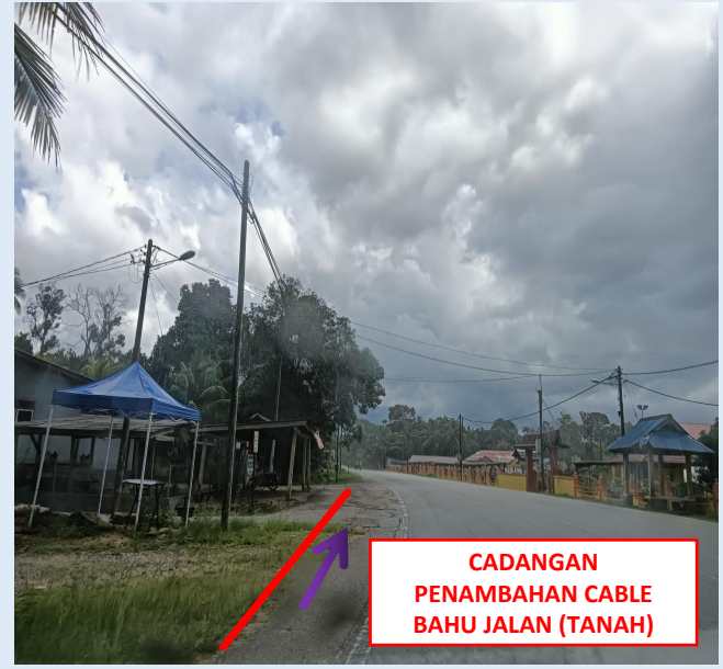
GAMBAR 24 : KAWASAN KERJA MELIBATKAN LALUAN CABLE (BERTANAH)
