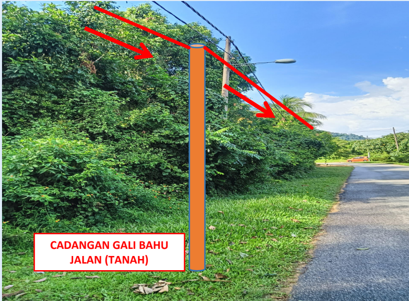
GAMBAR 19 : KAWASAN KERJA MELIBATKAN TANAM TIANG 7.5M (BERTANAH)
